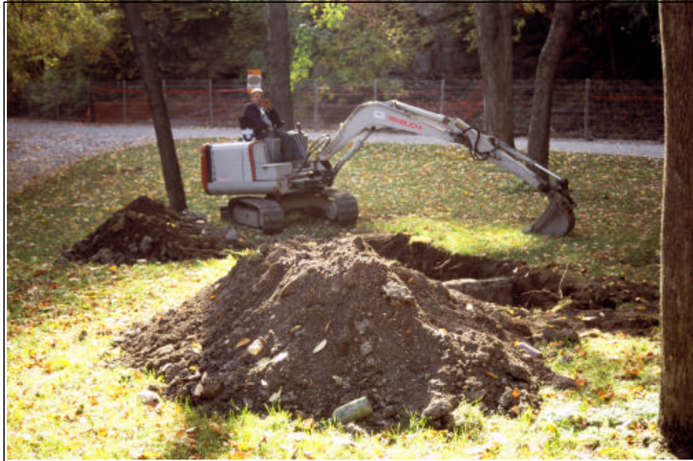
Photo 5 : Couche de résidus de combustion provenant d'un dépotoir et excavée mécaniquement dans les quatre tranchées (MTL04-25-15-D1-19)
