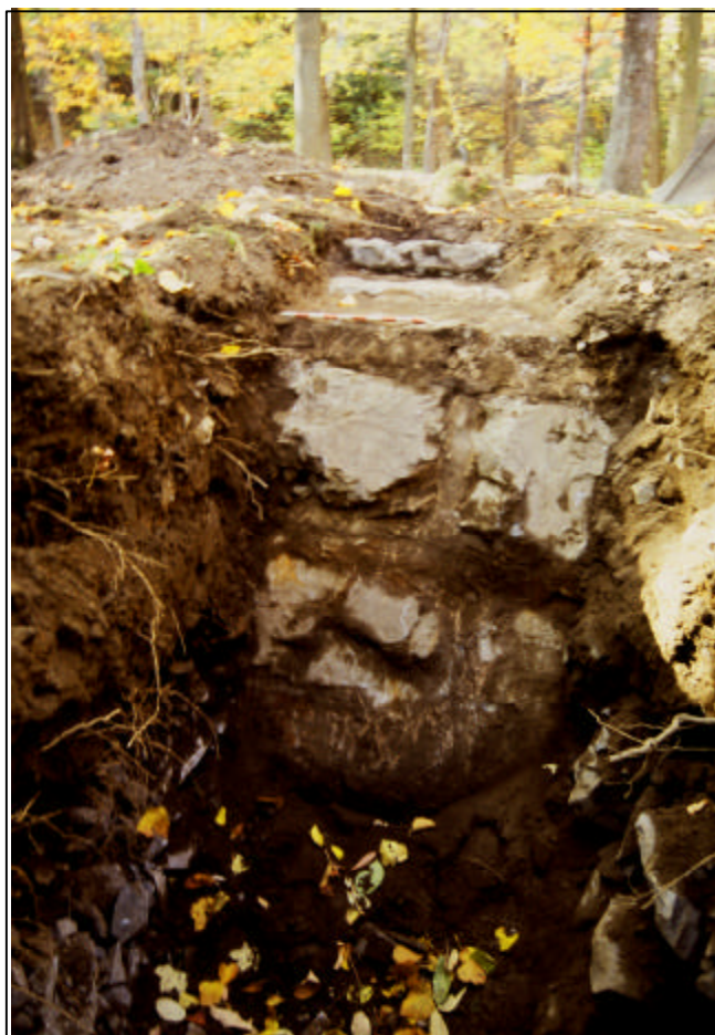
Photo 3 : Ouverture murée dans le mur est de l'ancien réservoir (MTL04-25-15-D1-34)
