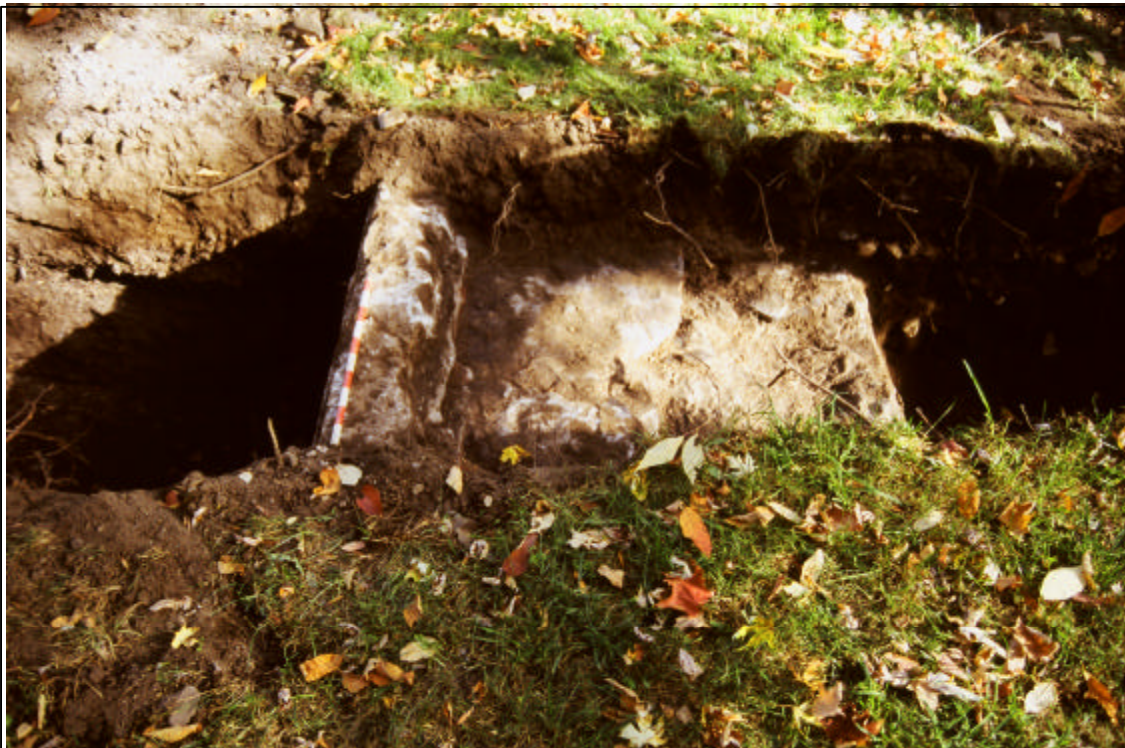
Photo 8 : Sommet du mur sud de l'ancien réservoir en partie recouvert d'un crépi localisé à quelques centimètres sous la surface (MTL04-25-15-D1-20)
