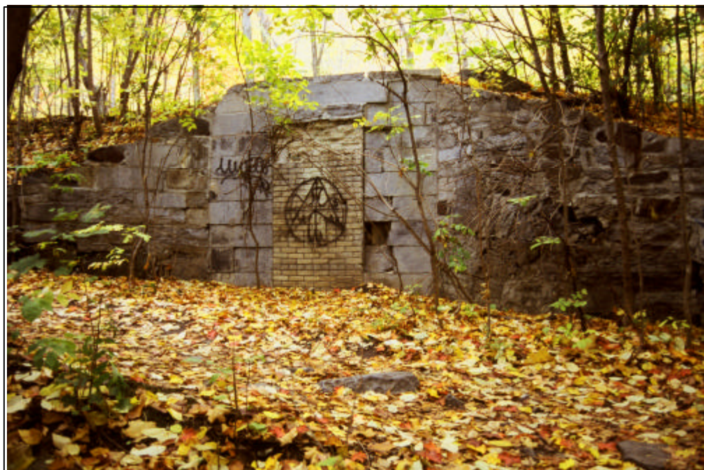
Photo 3 : Ouverture murée dans le mur est de l'ancien réservoir (MTL04-25-15-D1-34)
