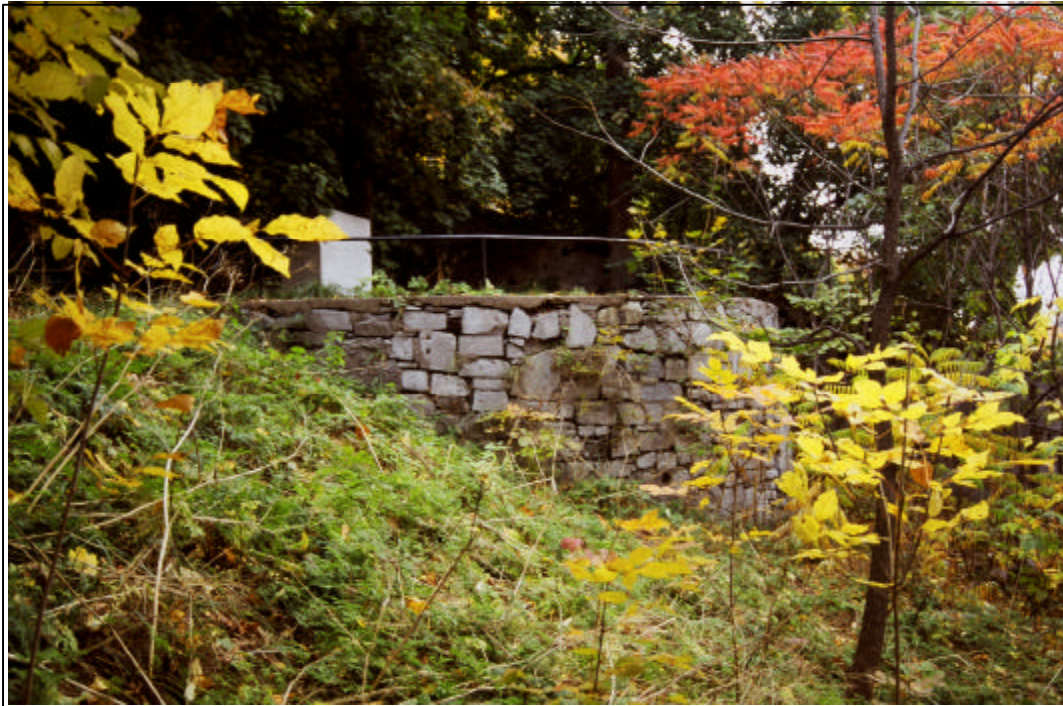
Photo 2 : Mur de support de la plate-forme sur lequel repose le monument commémorant le décès de Simon McTavish (MTL04-25-15-D1-33)
