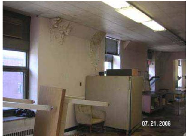
Traces d'infiltration au 1<sup>er</sup> étage de l'aile de la gare-hôtel
