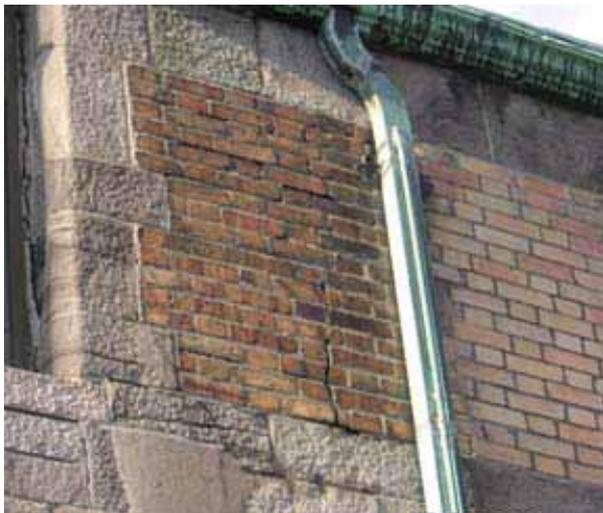
Fissure dans la maçonnerie de brique
