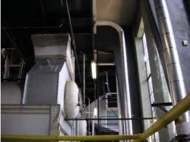
État actuel de l'intérieur de la chaufferie. On note le revêtement de tuiles vernissées, le fenêtrage à verre simple dans des cadres d'acier et la structure de béton de la toiture laissée apparente.
