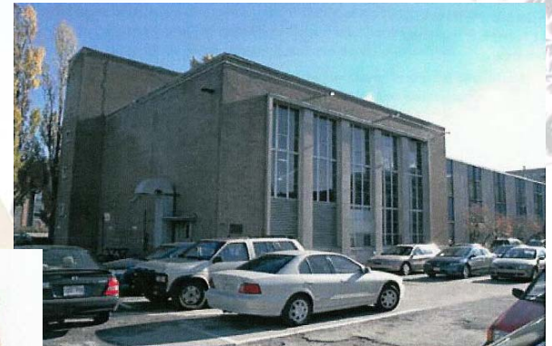
Figure 10 Chaufferie. Groupe Cardinal Hardy
