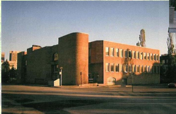
Figure 12 Bâtiment administratif. Groupe Cardinal Hardy
