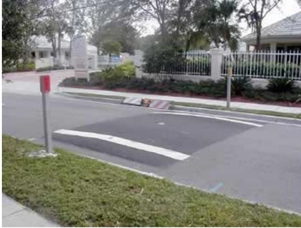
Les dos d'âne allongés font partie des différents aménagements pouvant être mis en place pour forcer les véhicules à ralentir, par exemple aux abords des parcs et des écoles.
