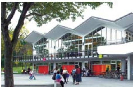
Pavillon du Lac-aux-Castors après la restauration, été 2006 © Ville de Montréal, Jean Landry.
