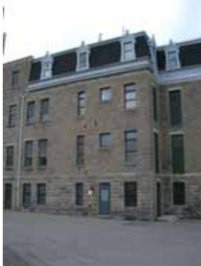
Figure 20 : REF 2006-04-06 LB 236. Façade ouest de l'aile ouest.
