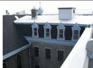
Figure 31 : REF 2006-04-06 LB 135. Vue d'ensemble des lucarnes de la face nord du corps principal. La présence des petites croix les surmontant et la conservation de la corniche contribuent au caractère distinctif de ce bâtiment.
