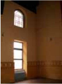
Figure 53 : REF 2006-04-06 YN 106. Détail d'une travée latérale.
