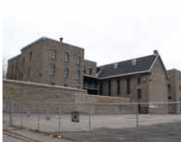
Figure 17 : REF 2006-04-06 YN 018. Vue générale vers le sud-ouest.
