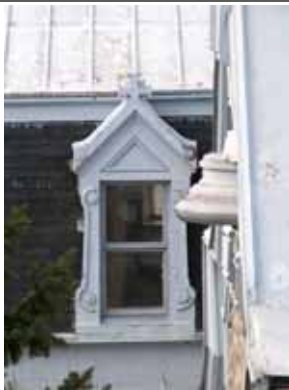
Figure 29 : REF 2006-04-06 YN 210. Détail montrant la lucarne, le brisis jadis couvert d'ardoise, et la toiture de tôle à baguettes.
