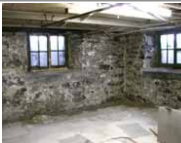
Figure 36 : REF 2006-04-06 LB 035. Détail de l'appareil de Pierre.
