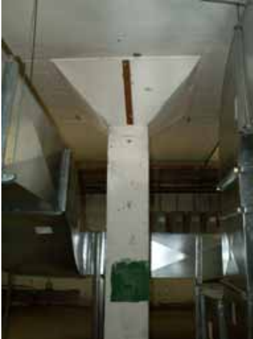
Figure 38 : REF 2006-04-06 YN 080. Colonne de béton à chapiteau.
