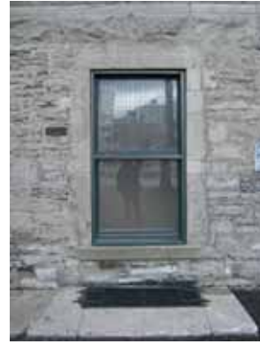
Figure 28 : REF 2006-04-06 LB 223. Fenestration typique, de pin.
