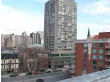
Figure 115 : REF 2006-04-06 YN 198. La construction de bâtiments en hauteur dans le voisinage est venue modifier le rapport au boulevard et à la falaise.
