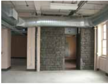
Figure 33 : REF 2006-04-06 LB 175. État de préservation du mur original; noter que l'appui de la fenêtre a été coupé pour permettre l'ouverture d'une porte.
