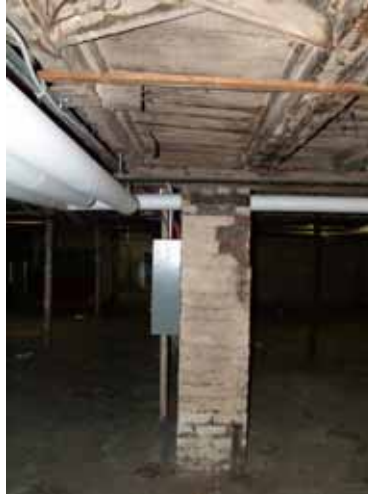
Figure 39 : REF 2006-04-06 YN 054. Colonne de renfort en brique.
