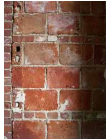
Figure 43 : REF 2006-04-06 LB 195 Détail latéral de brique et de blocs de terra-cotta.
