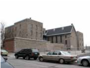
Figure 56 : REF 2006-04-06 YN 014. Vue des murs nord et est de la buanderie.
