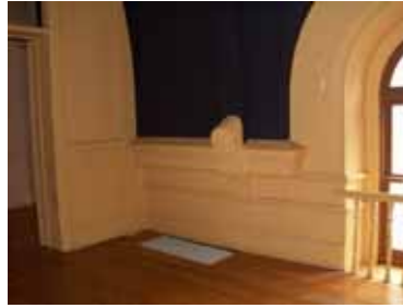
Figure 54 : REF 2006-04-06 YN 154. Détails à l'étage, coin sud-ouest.
