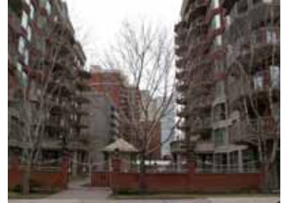
Figure 117 : REF 2006-04-06 YN 026. La juxtaposition des tours s'est faite sans Plan d'ensemble et le résultat laisse à désirer. La transition entre le Centre des affaires et la zone résidentielle reste à articuler.
