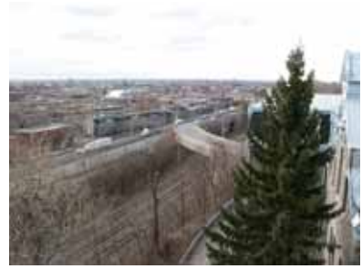
Figure 111 : REF 2006-04-06 YN 215. La construction de l'autoroute Ville-Marie dans les années soixante fut faite en partie aérienne et en partie souterraine. La bretelle d'issue Guy se trouve à passer au-dessus des voies ferrées.
