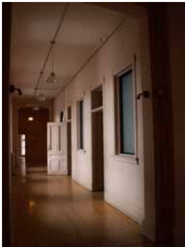
Figure 44 : REF 2006-04-06 YN 125. Corridor transversal du rez-de-chaussée.
