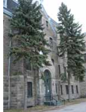
Figure 22 : REF 2006-04-06 LB 241. Vue générale vers l'entrée.
