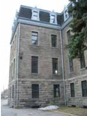
Figure 21 : REF 2006-04-06 LB 247. Façade est de l'aile ouest.
