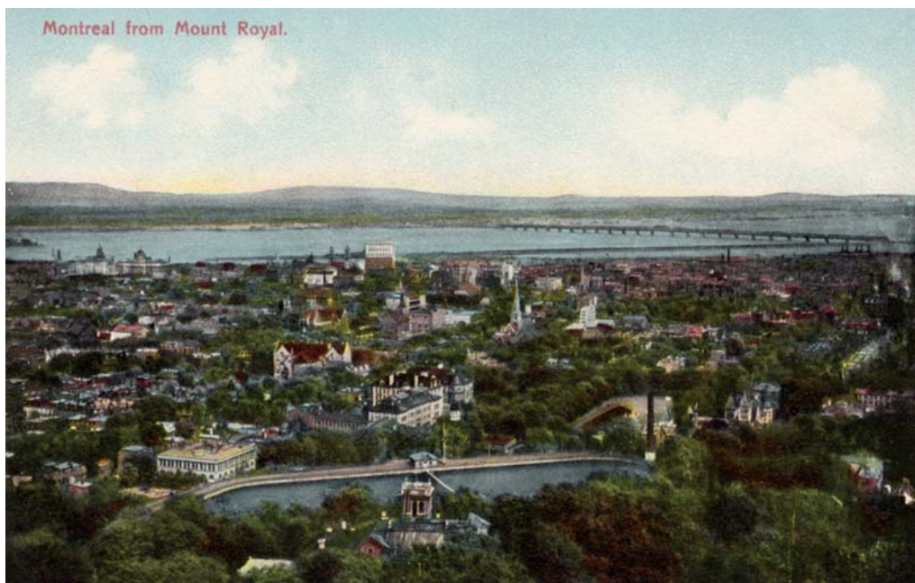
Carte postale montrant le réservoir McTavish avant son recouvrement par une dalle de béton en 1947
