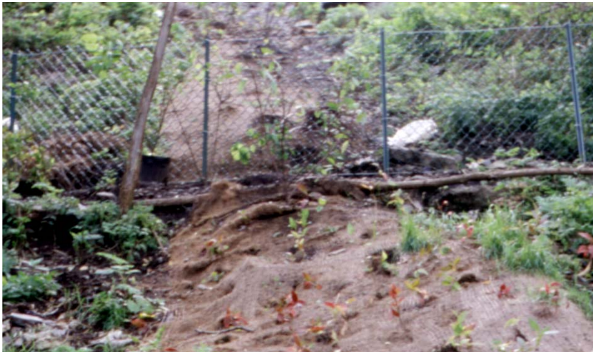
Ancienne crevasse devant le belvédère Camillien-Houde, exemple de plantation de jeunes arbustes sur un remblai de terre surmonté d'un tapis biodégradable en fibre de noix de coco
