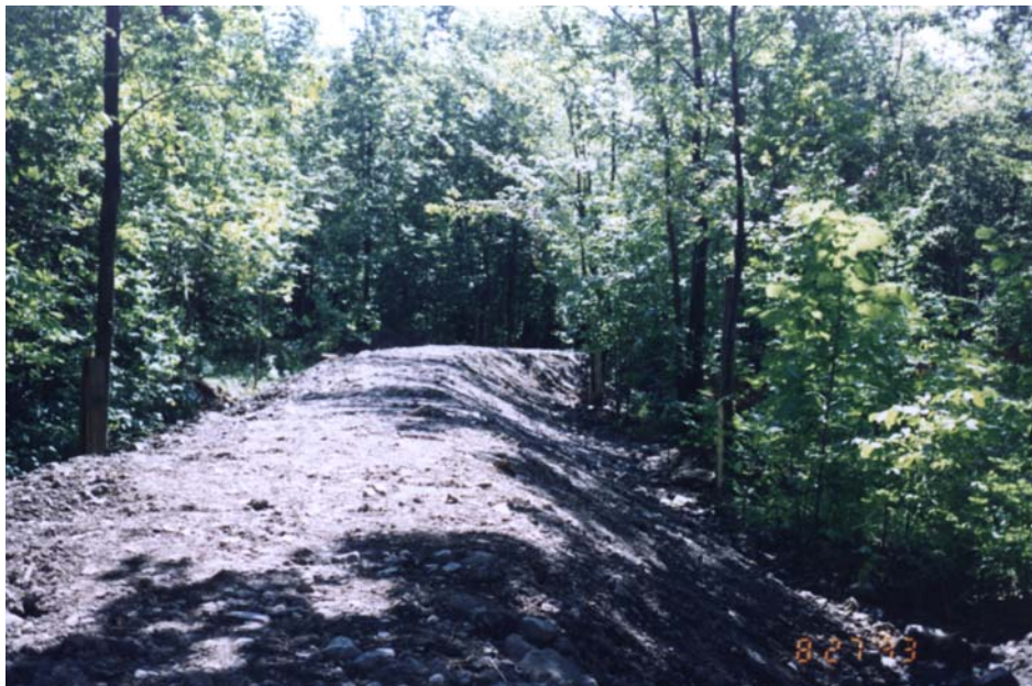
La même digue après remblayage, avant la plantation d'arbustes
