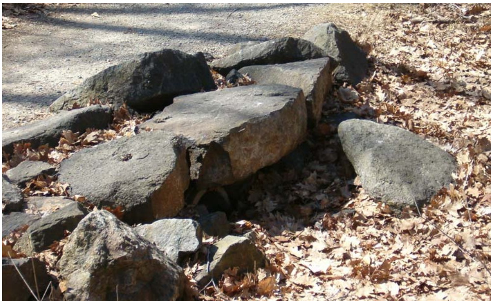
Ensemble de roches récupérées mises en place pour camoufler les tuyaux
