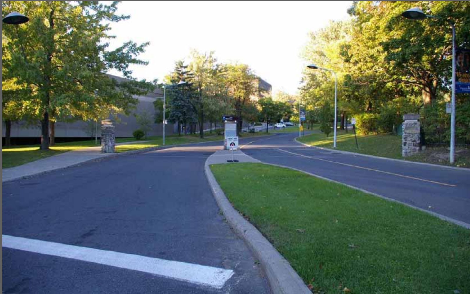
Une large entrée véhiculaire à l'U. de M. à l'intersection des avenues Queen Mary et Decelles
