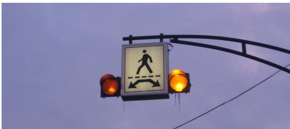
Panneau lumineux de signalisation de passage pour piétons
