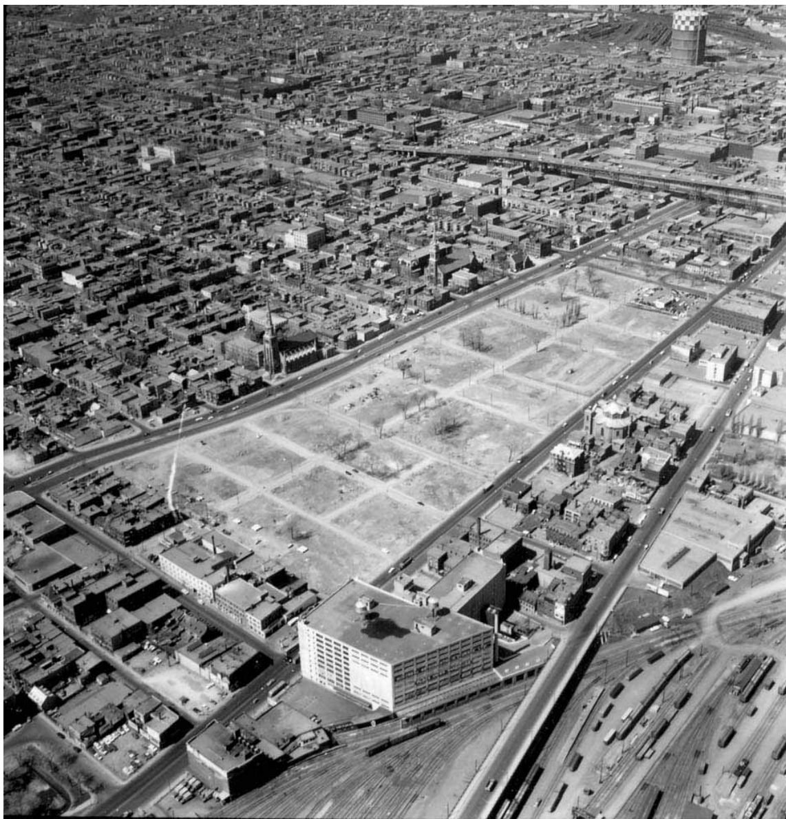
Vue aérienne vers le nord-est du secteur déblayé, 2 mai 1964. Source : Service des archives de la Ville de Montréal, 2 mai 1964, U-124.
