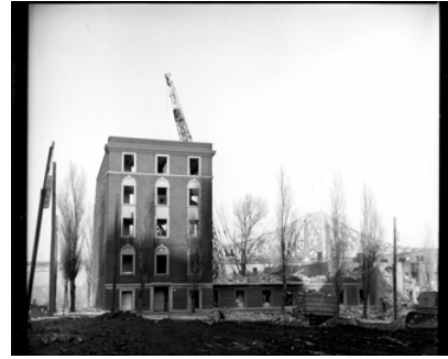
En cours de démolition Source : Archives de la Ville de Montréal U-98-10
