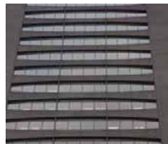
Mur de béton préfabriqué
