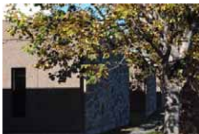
Exemple du traitement de maçonnerie des volumes donnant sur la façade Viger.
