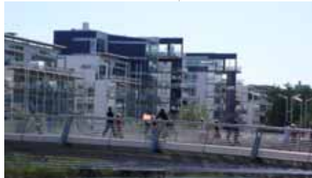
70 | POINT PIÉTONNIER, HAMMARBY SJÖSTAD
