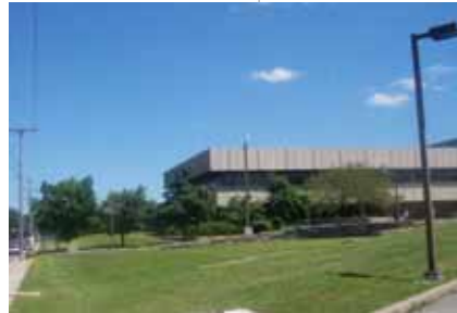
33 | 1500, RUE OTTAWA, BÂTIMENT SURÉLEVÉ
