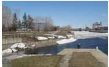
46 | REMBLAI DU BASSIN 4
