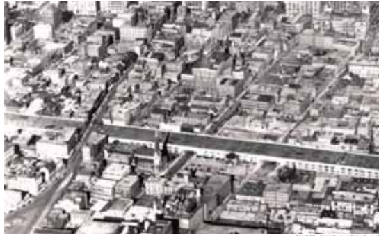
26 | PHOTO AÉRIENNE MONTRANT LE VADUC FERROVAIRE EN CONSTRUCTION AU COURS DES ANNÉES 1940
