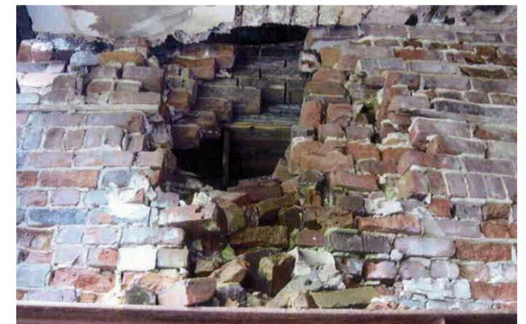
Effondrement d'une partie du mur porteur, au-dessus d'une poutre. On y voit l'extrémité d'une poutre qui supporte un élément de corniche extérieure. Celle-ci n'a plus aucun support.
