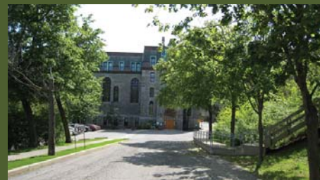
4 Face latérale de l'ancien Séminaire de philosophie
