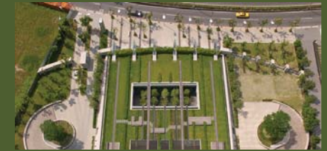
3 Toit-terrace-belvédère - Siège social de Lite-On-Electronic, Taipei, Taiwan
