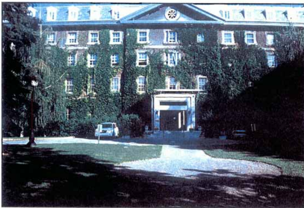
Photo 13 : Zone d'intervention H6 (photo M. Royer)
