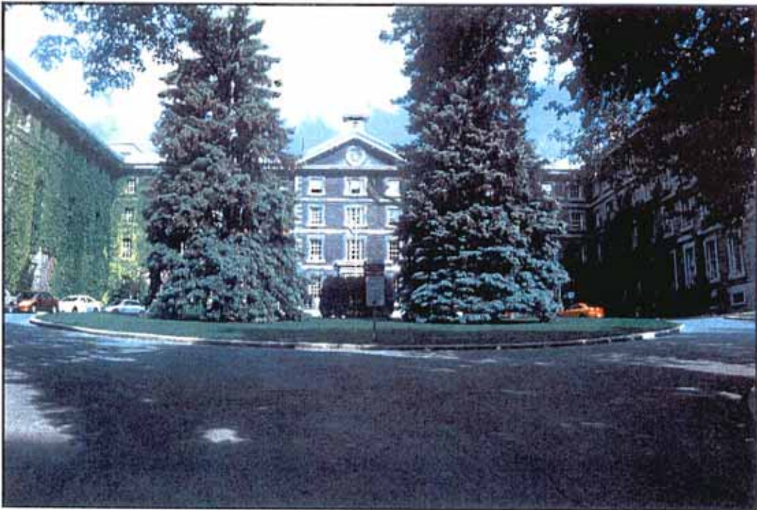
Photo 18 : Zone d'intervention H3 (photo M. Royer)
