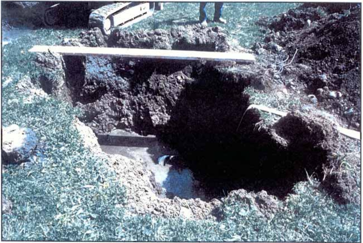
Photo 21 : Sous-opération 52A (photo M. Royer)
