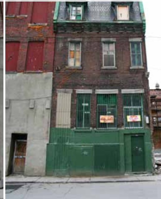
Détails de façades rue Clark
