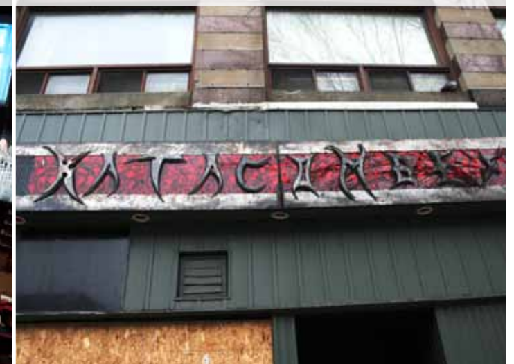
Les Katakombes ont bénéficié de l'aide de SDA pour leur relocalisation
