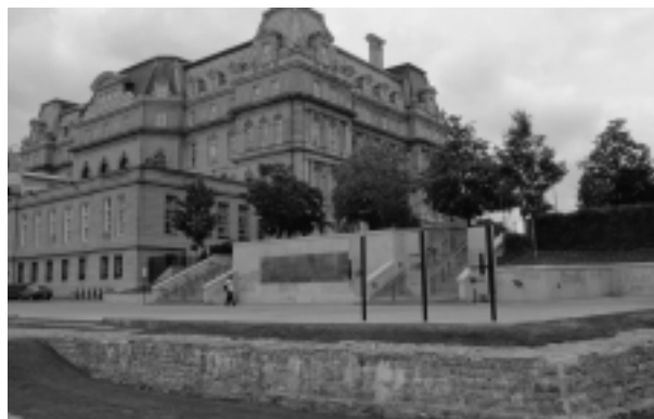
Au parc du Champ-de-Mars, les vestiges d'un front complet de la fortification bastionnée de Montréal sont exposés sur une longueur de plus de 250 mètres. La fortification est ici composée d'une escarpe, d'une contrescarpe et d'un fossé. Photographie: R. Martel.
