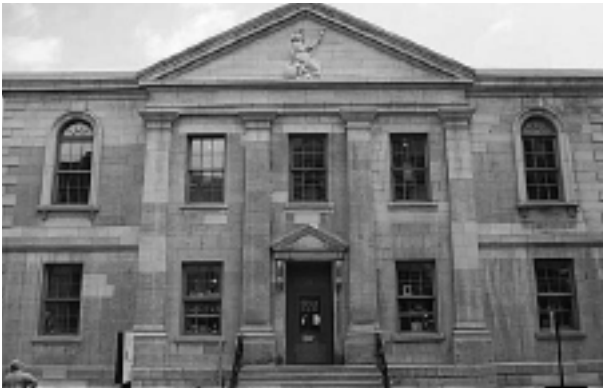
24.E.39 Ancienne Douane (1836-1838), John Ostell, architecte, 150, rue Saint-Paul Crédits photographiques : Société de développement de Montréal
