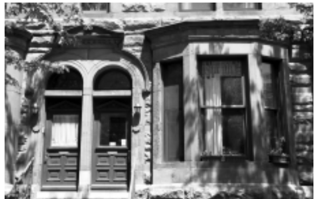
24.E.7 1419 à 1441, rue Pierce, maisons en rangée William D. Stroud, détail du rez-de-chaussée.
