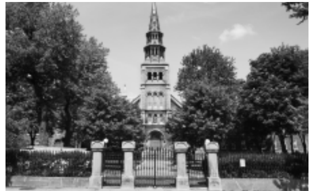
24.E.10 La chapelle de l'Invention-de-la-Sainte-Croix, érigée en 1874, fait partie intégrante du complexe de la maison mère des Sœurs Grises. Crédits photographiques : Réjean Martel
