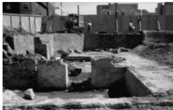
BjFj-067 Les vestiges archéologiques du marché Saint-Laurent ont été conservés in situ lors de l'aménagement de la place de la Paix.
