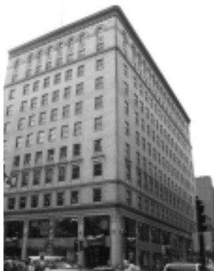
24.E.14 Le Castel Building, situé au 1410, rue Stanley est construit en 1926 par les architectes Robert Henry Macdonald et George Allen Ross dans l'esprit de l'École de Chicago. À l'époque, ce bâtiment innovait par ses larges vitrines d'une hauteur de deux étages. Crédits photographiques : Isabelle Bouchard
