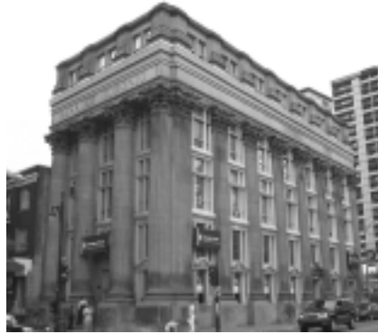
24.E.8 Succursale bancaire construite en 1908 par les architectes Ross et Macdonald, 1601, rue Sainte-Catherine Ouest. Crédits photographiques : Isabelle Bouchard
