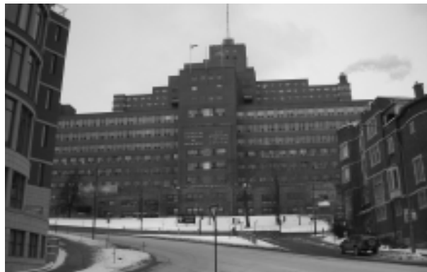
24.E.3 Hôpital général de Montréal. Crédits photographiques : Patri-Arch Patrimoine et Architecture
