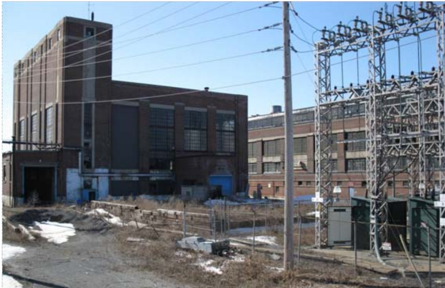
Figure 18 : Photo actuelle de la centrale thermique.
