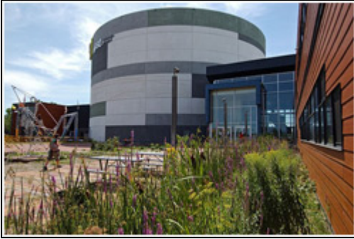
Figure 3.1 Bassin de bio- rétention et marais filtrant Tirée de La Tohu, Site Internet (2009)
