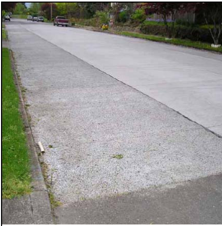
Figure 4.3 Bande d'asphalte perméable dans une avenue résidentielle de Portland Tirée de Portland (2007) Green streets tour map
