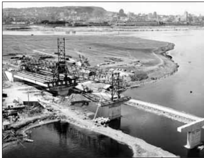
Figure 1.31 Le pont Champlain permettra, notamment, le développement de l'île des Sœurs, 1960.
