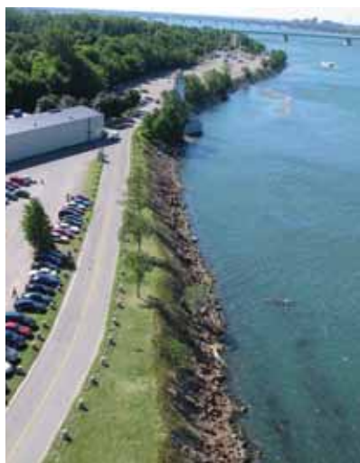
Figure 2.6 Remblais de l'île Sainte-Hélène.
