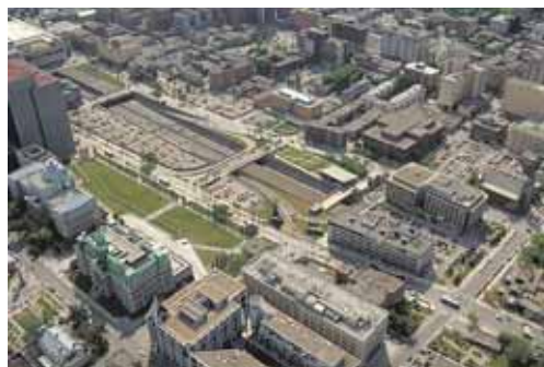
Figure 5.1 Vue aérienne de la tranchée de l'autoroute Ville-Marie à l'arrière du Champ-de-Mars.
