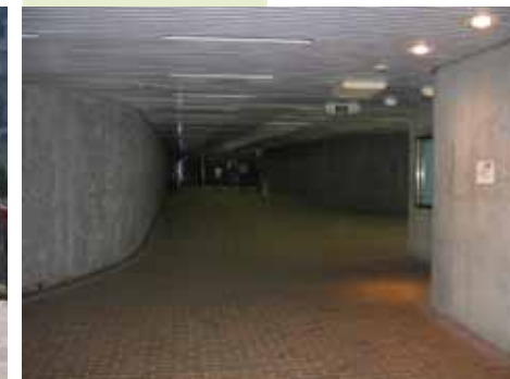
Figure 5.28 Le tunnel piétonnier sous la sortie Gosford de l'autoroute Ville-Marie, en direction du Vieux-Montréal
