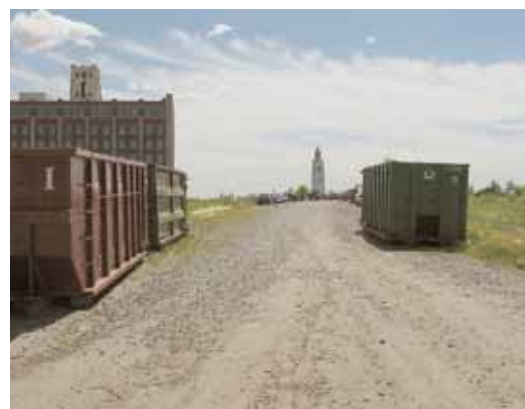
Figure 6.2 Terrains en voie d'être décontaminés pour un développement résidentiel dans le faubourg Québec.
