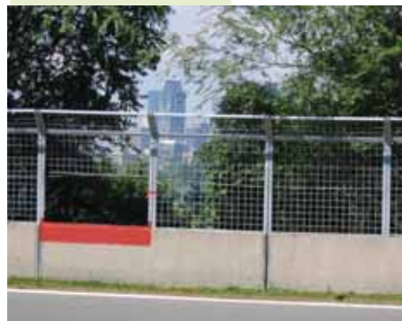
Figure 5.50 Clôture sur la piste Gilles-Villeneuve bloquant l'accès à la berge.
