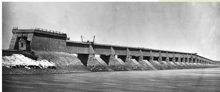
Figure 1.12 Constitué d'un tube métallique posé sur des piles de pierre calcaire, le pont Victoria sera décrit comme la huitième merveille du monde , 1873.
