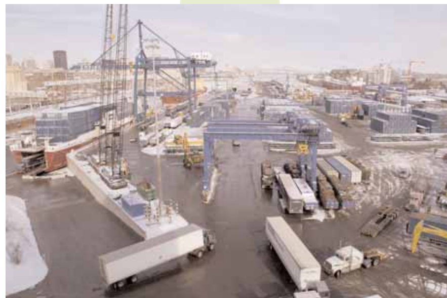
Figure 4.5 Activités portuaires sur le quai Bickerdike.
