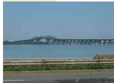
Figure 6.30 Du Technoparc, une vue sur le fleuve et sur le pont Champlain.
