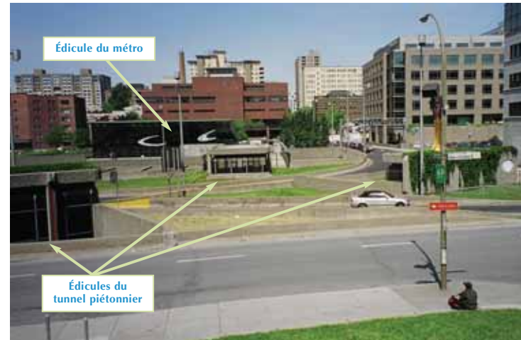
Figure 5.26 Sortie d'autoroute à la station de métro Champ-de-Mars à l'angle des rues Saint-Antoine et Gosford.
