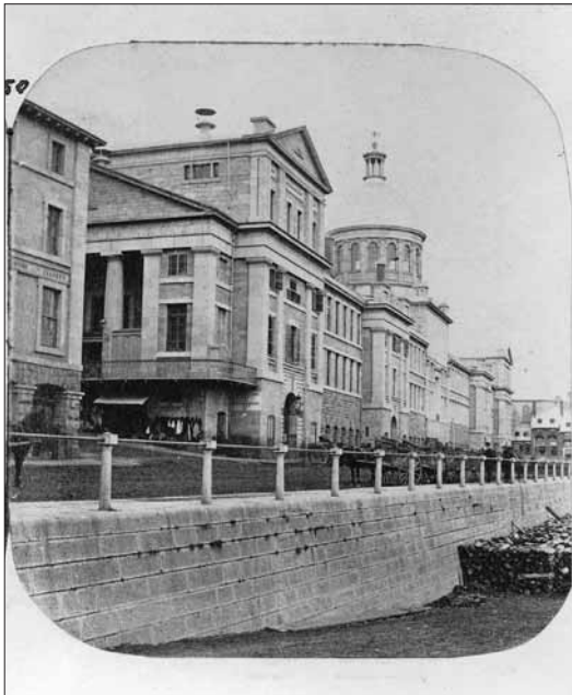
Figure 1.8 Les travaux de la Commission du havre de Montréal consistaient notamment à surélever la rue des Commissaires et à ériger des murs et des rampes d'accès, 1859.
