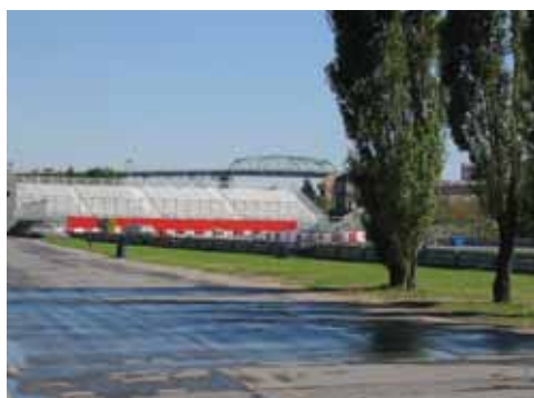
Figure 6.6 Gradins installés en mai pour le Grand Prix F1 et démantelés à la fin août, après le Molson Indy.
