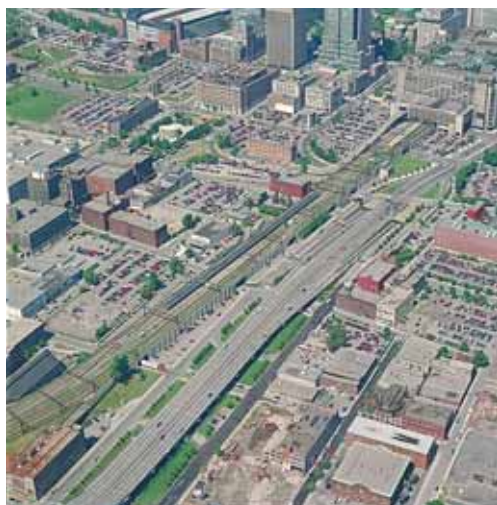
Figure 5.2 L'autoroute Bonaventure : une frontière urbaine et son no man's land de stationnements du faubourg des Récollections.
