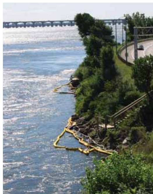
Figure 6.1 Captage d'écoulements d'hydrocarbures dans le secteur du Technoparc à proximité du pont Victoria.
