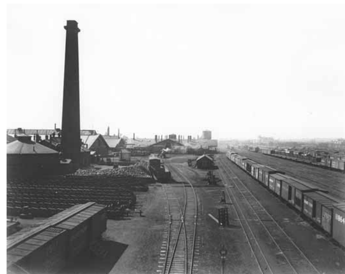
Figure 1.14 Le Grand Tronc érige, à partir de 1856, un immense complexe de hangars et d'ateliers d'entretien au milieu d'une vaste cour de triage, 1898.
