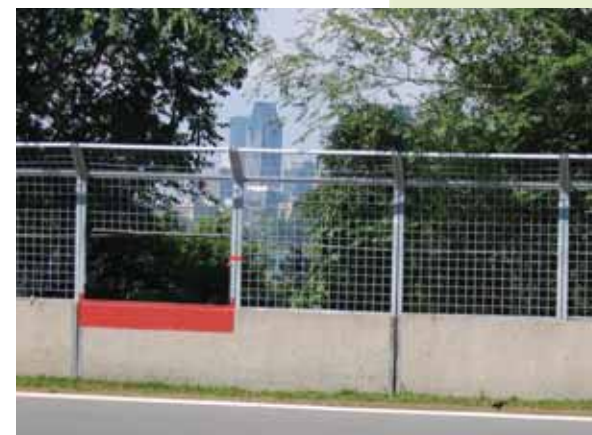
Figure 6.4 Clôture sur le circuit Gilles-Villeneuve bloquant la vue sur le fleuve et l'accès à la berge.
