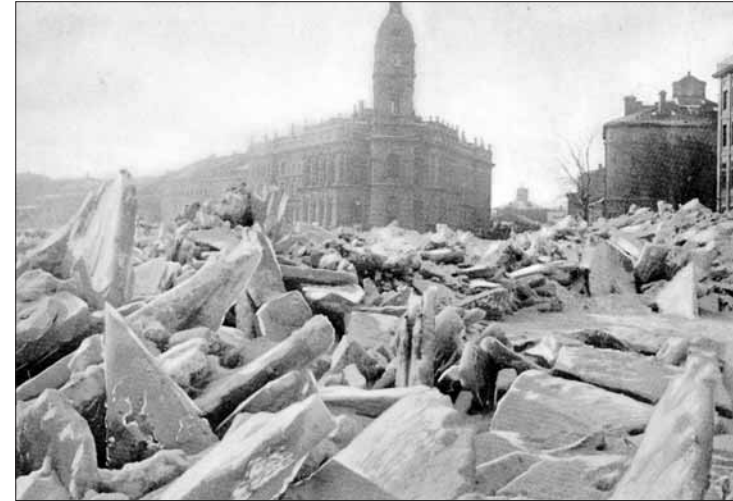
Figure 1.21 Dommages causés par les glaces avant la construction du mur de protection en face de la place Royale, 1870.
