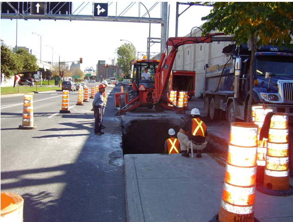
Photo 13 : Exécution des travaux de fouilles archéologiques (07E142-47) sur le trottoir de la rue Nazareth, au nord de la rue William.
