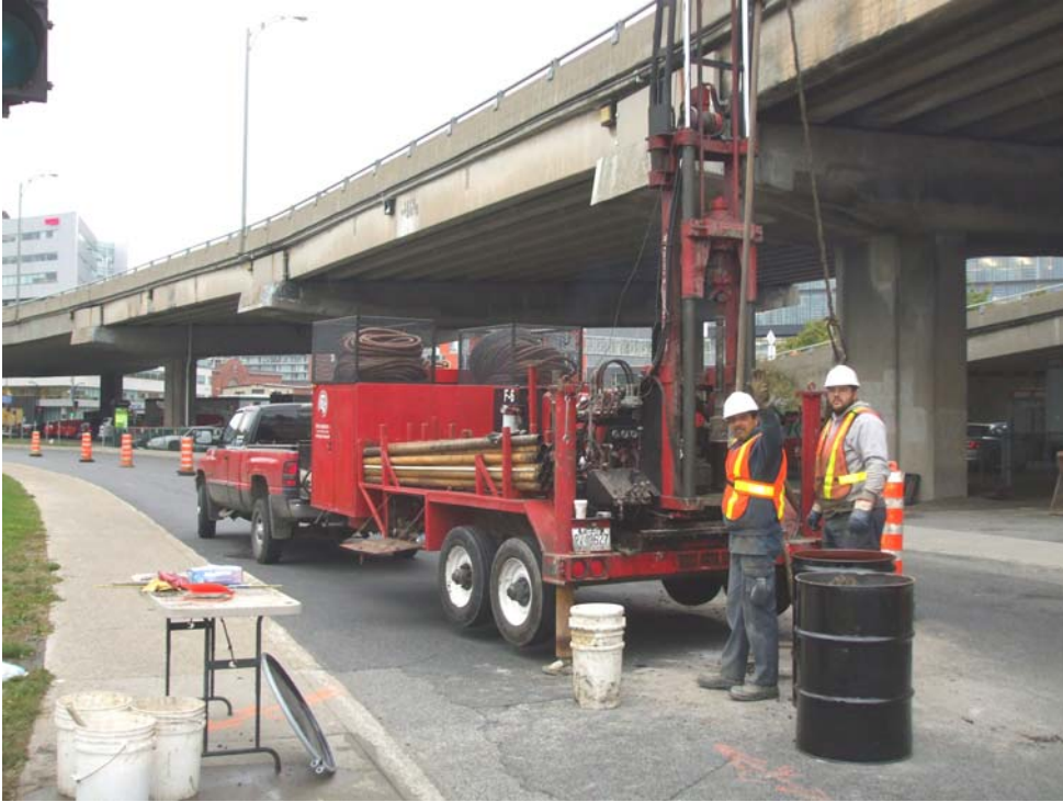
Photo 9 : Travaux de forage (07E142-41) réalisés sur le rue Nazareth, à la hauteur de la rue Brennan.
