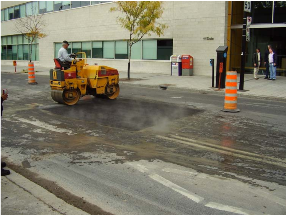
Photos 18-19 : Exécution des travaux de pose d'asphalte sur la rue Duke (tranchées d'observation 07E142-43 et 44), entre les rues Wellington et Ottawa.
