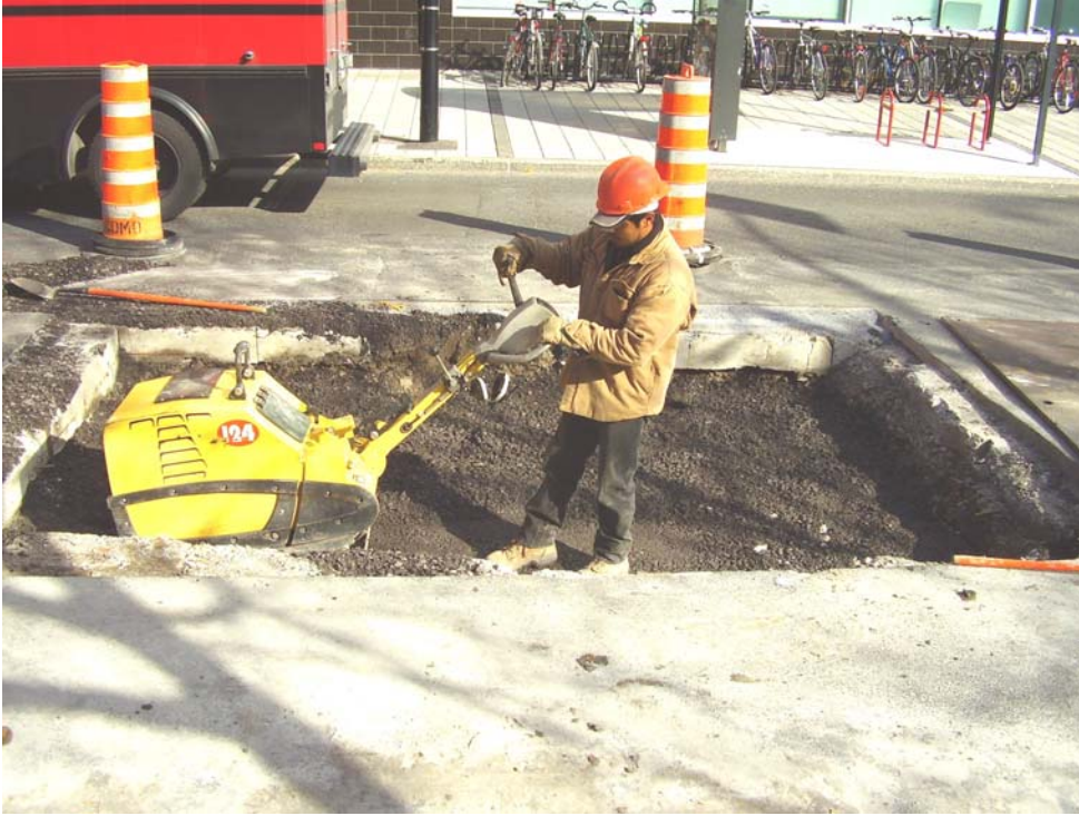
Photo 16 : Travaux de réfection. Remplissage et compactage d'une tranchée d'observation (07E142-43.)
