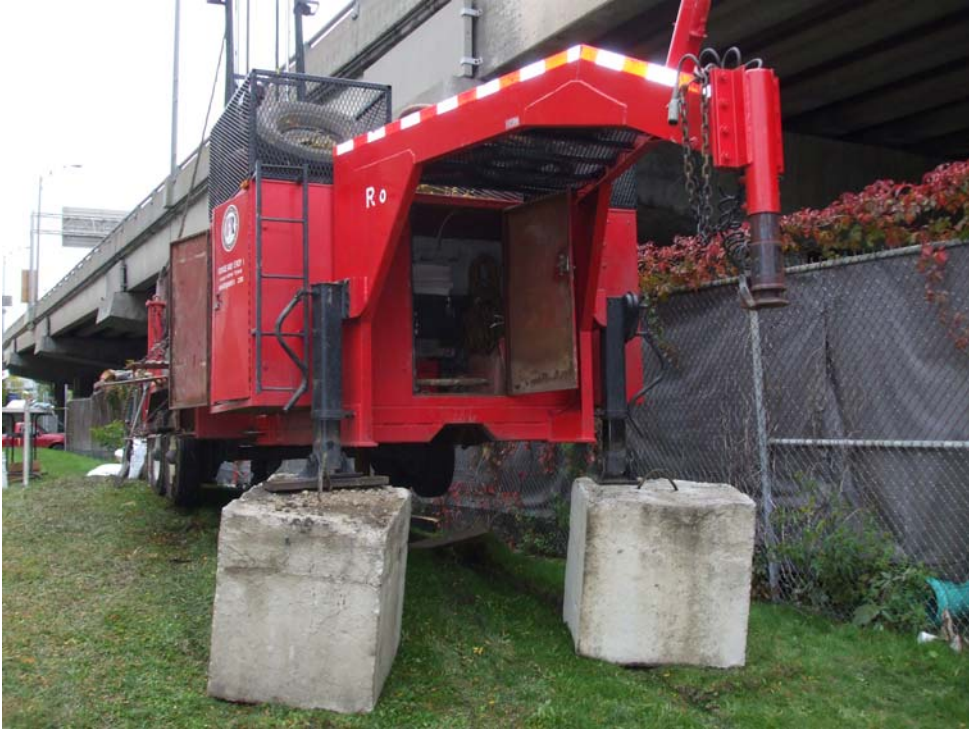
Photo 15 : Pieds à piston de la foreuse reposant sur des bloques de béton afin de stabiliser la foreuse lors de travaux sur un site pentu (07E142-24).
