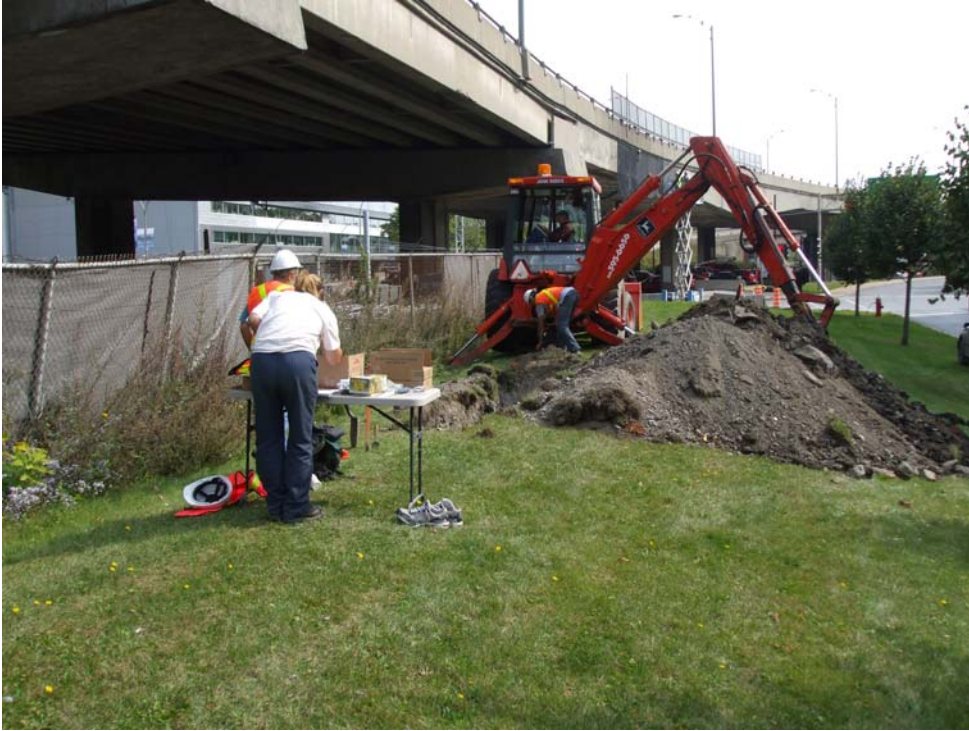
Photo 3 : Travaux de tranchée d'observation réalisés sur une surface gazonnée (07E142-29) longeant la rue Nazareth.
