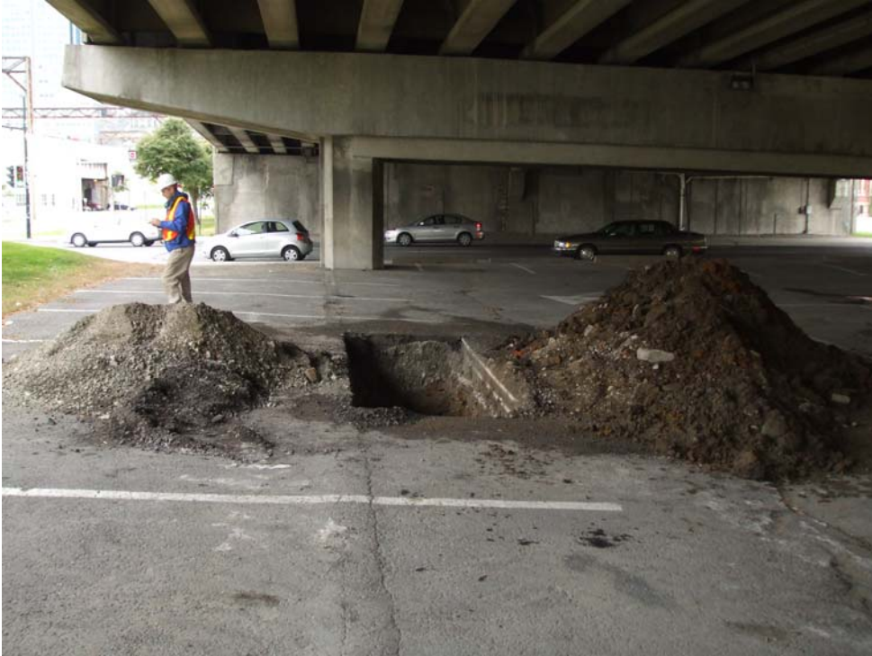
Photo 7 : Travaux de tranchée d'observation (07E142-17) réalisés sur une surface asphaltée (stationnement privé), sous l'autoroute Bonaventure.
