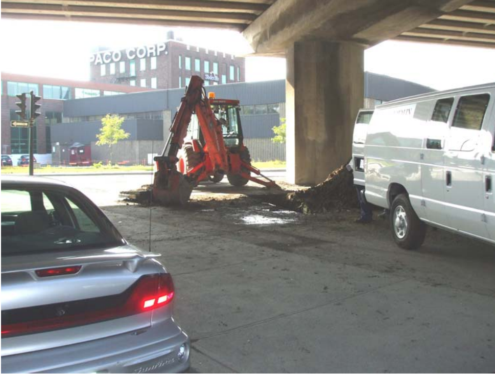
Photo 6 : Travaux de tranchée d'observation (07E142-35) réalisés sur une surface asphaltée (stationnement Ville de Montréal), sous l'autoroute Bonaventure.
