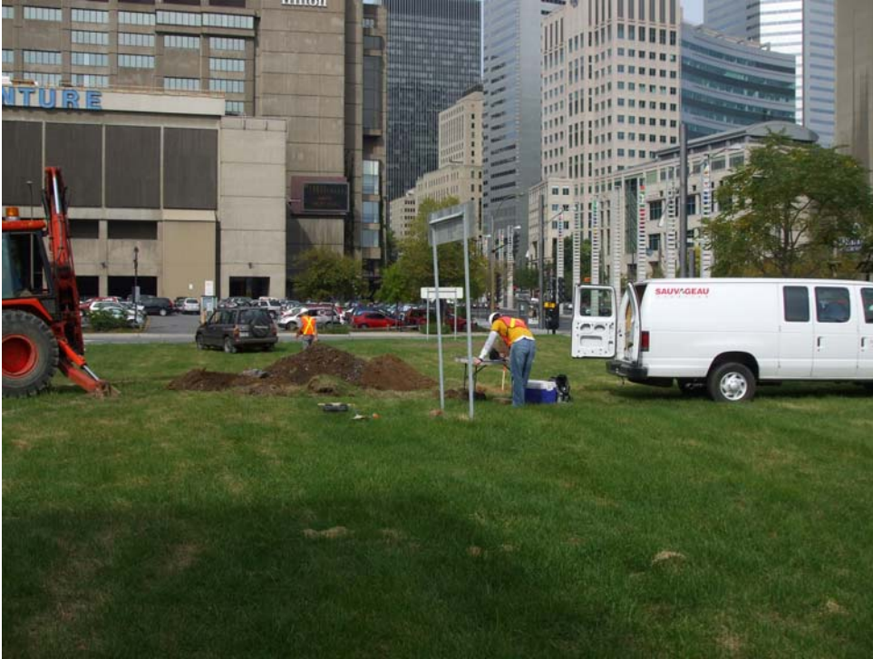
Photo 1 : Travaux d'une tranchée d'observation (07E142-3) sur le terrain appartenant au Ministère du Transport du Québec.
