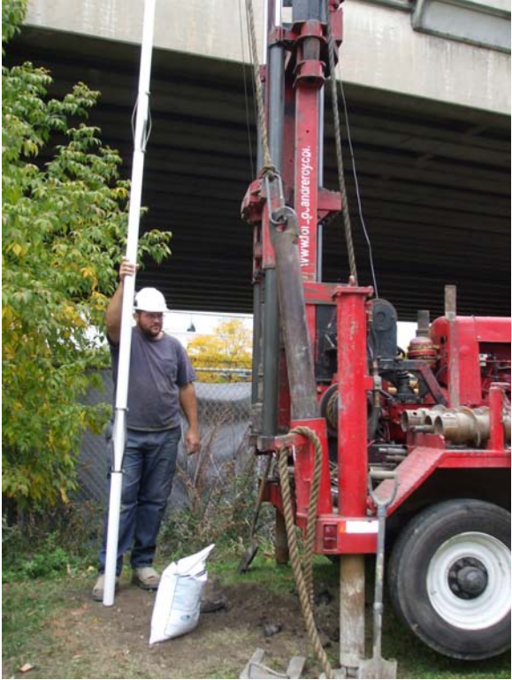
Photo 10 : Installation du puits en PVC muni de centralisateurs (07E142-31)
