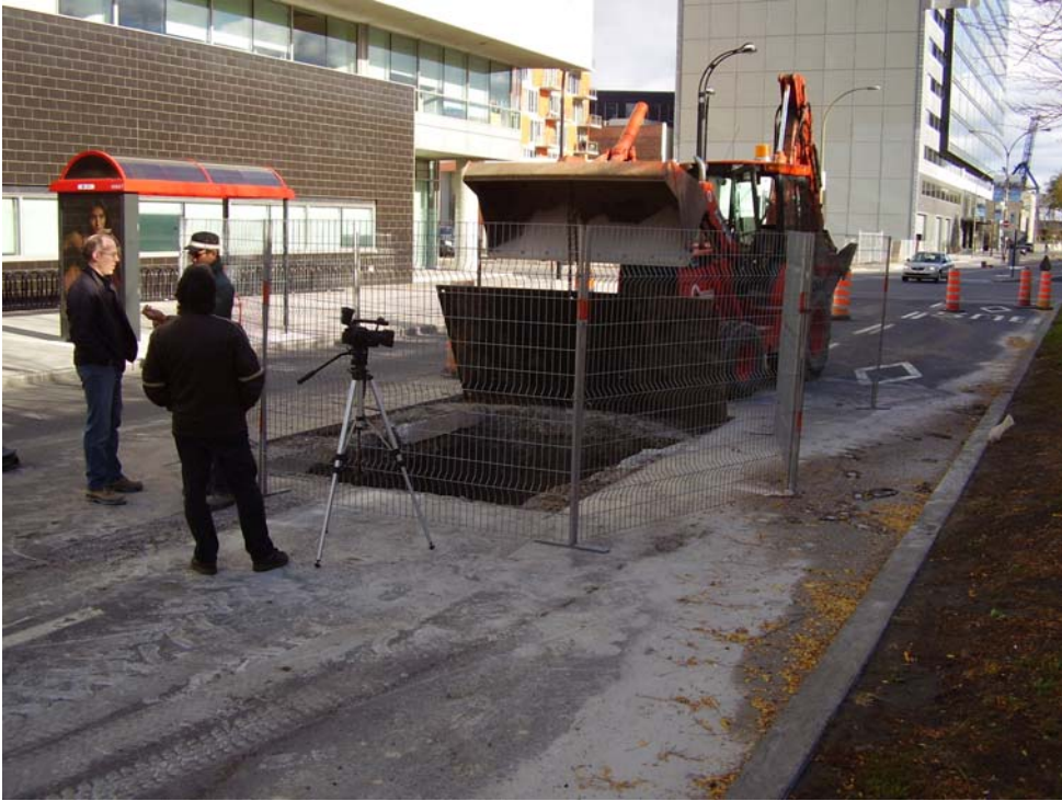
Photo 14 : Ceinture de clôtures entourant la tranchée 07E142-43 et pose de plaques de métal pour permettre la circulation automobiles pendant l'arrêt des travaux.
