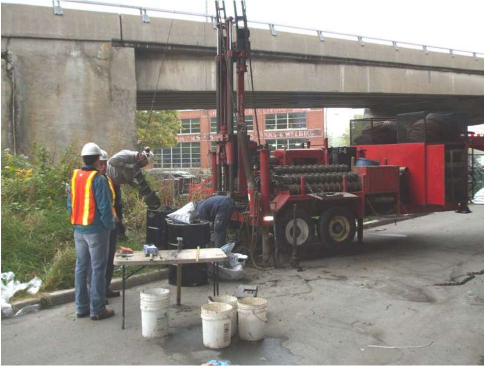
Photo 8 : Travaux de forage réalisés sur le domaine public (07E142-40), le long du tablier de l'autoroute Bonaventure (côté est), à la hauteur de la rue Brennan.
