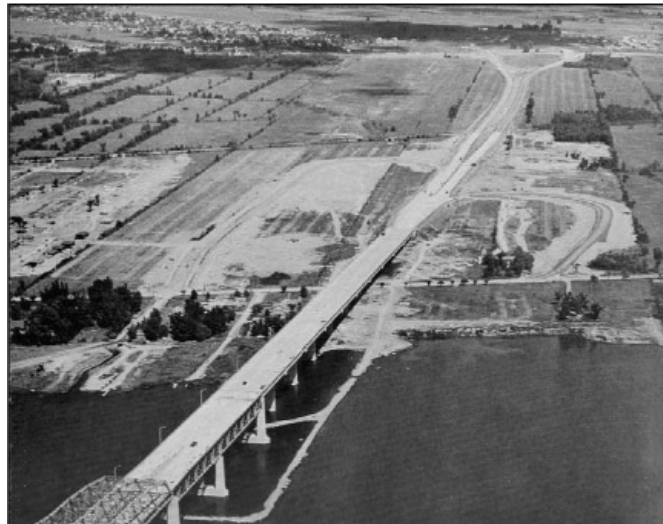
Figure 5.6 La tête du pont Champlain à Brossard, pendant la construction Source : Conseil des ports nationaux
