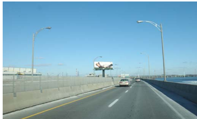
Figure 5.42 (a), (b) et (c) L'autoroute Bonaventure – Séquences 4, 5 et 6 Les panneaux publicitaires placés le long du parcours de l'autoroute Bonaventure dominent le champ visuel.
