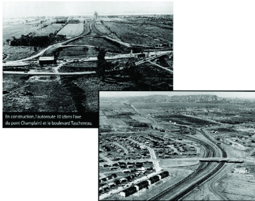
Figure 5.14 L'autoroute 10 en construction
