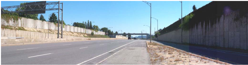
Figure 4.14 L'autoroute 19 – Laval, Séquence 2 Le mur antibruit est en rupture avec le milieu traversé.
