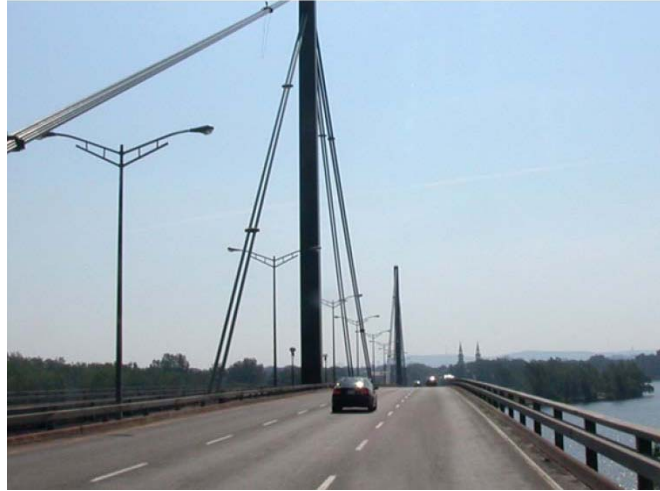
Figure 4.15 L'autoroute 19 – pont, Séquence 3
