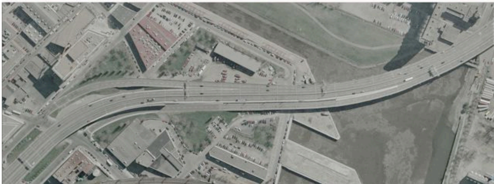
Étape-2: Construction de bretelles élargies, 8 traversées dir. sud et deux dir. nord
