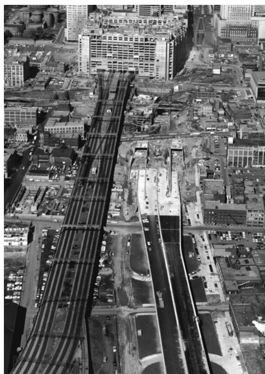
Vue aérienne de la construction de l'autoroute Bonaventure et des accès à l'autoroute Ville-Marie en 1966. (Source : Ville de Montréal. Gestion de documents et archives. B-32-11.)
