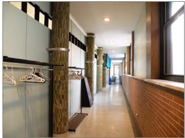
Les bas-côtés de la chapelle servant d'espaces de circulation, avec les colonnes recouvertes de céramique et auxquelles sont attachées par des ceintures métalliques les parois ajoutées.
