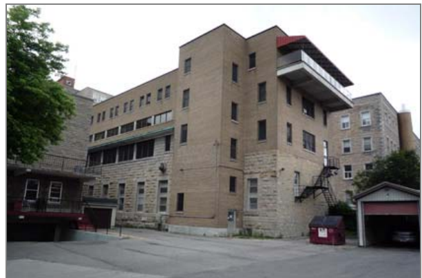
Les façades latérale nord et arrière de l'aile transversale, avec la cage d'escalier latérale et le balcon à l'étage contenant des chambres. On aperçoit l'aile Faillon à gauche, un petit garage à l'arrière de l'aile perpendiculaire et l'ancien bâtiment des ateliers en arrière plan à droite. Photo : Cardinal Hardy
