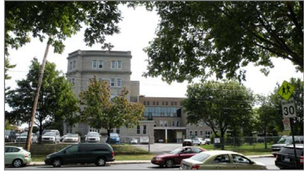
Vue de l'ensemble du côté nord (rue Faillon).
