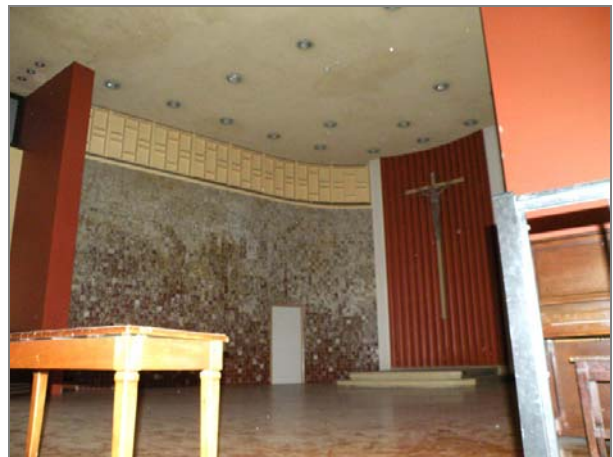
Vue d'une partie de l'ancien chœur de la chapelle (derrière le rideau de scène), avec la céramique murale.
