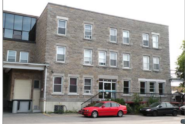
Façade nord de l'agrandissement de l'aile Faillon réalisé en 1940 pour loger les religieuses.
