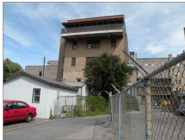
Remises, clôture, espaces de stationnement et de circulation derrière l'aile transversale.
