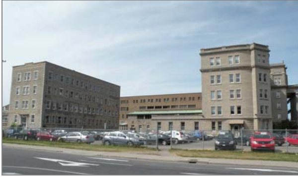
Vue de l'ensemble du côté sud (rue De Castelnau Ouest).
