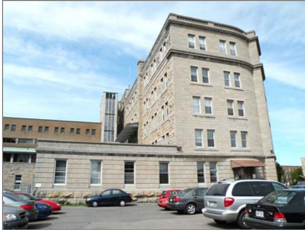
Façade latérale sud du corps principal. On aperçoit au centre la cage d'escalier ajoutée à l'arrière.
