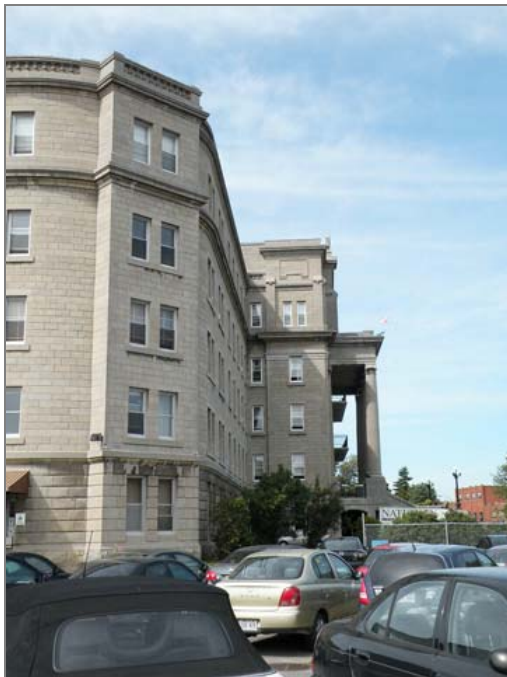
Angle arrondi de la façade principale et travée centrale en avancée.
