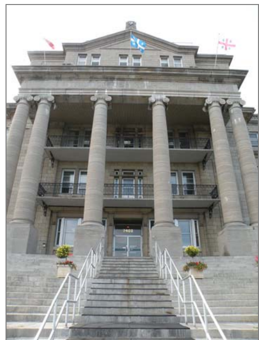
Travée centrale de la façade principale.
