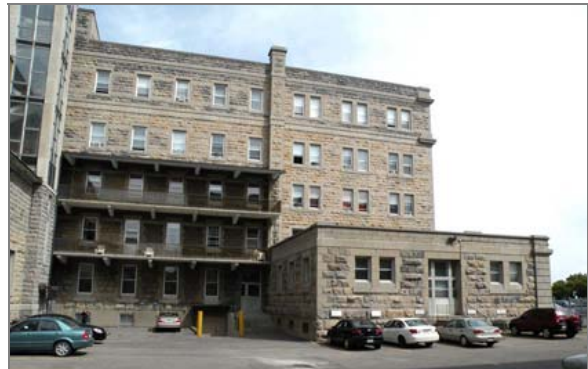
Moitié sud de la façade arrière du corps principal avec aile latérale d'un étage.
