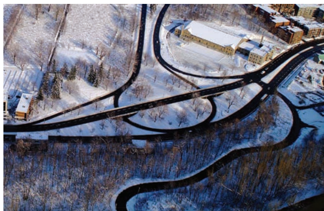
Le réaménagement de l'échangeur Côte-des-Neiges – Remembrance facilitera l'accès au parc du Mont-Royal.
