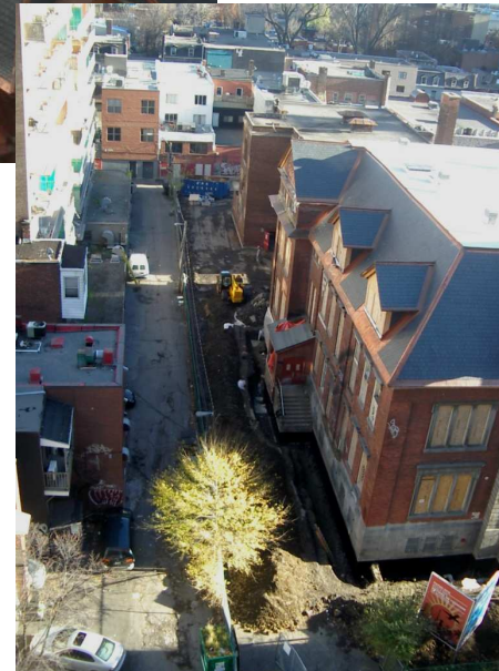
Travaux autour de l'école (automne 2010)
