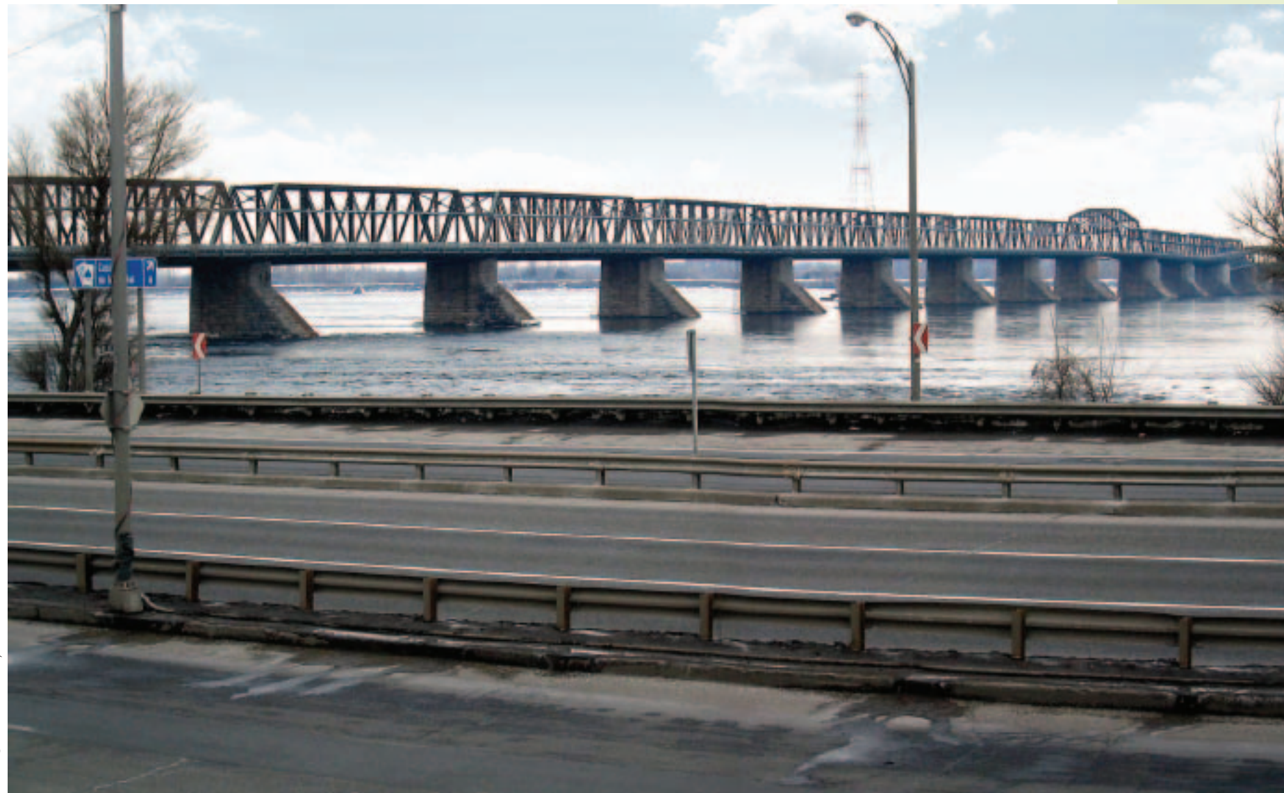
Photo : Christian Thiffault, Architectes
