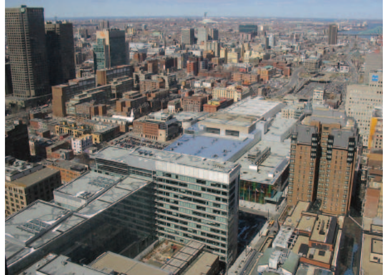
L'aménagement du Quartier international grâce au recouvrement de l'autoroute Ville-Marie
