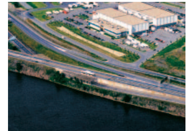
Escarpage des remblais dans le secteur du Technoparc
