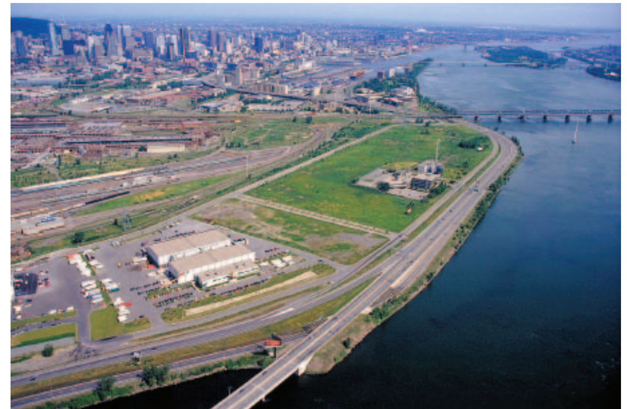
Berges envahies par l'autoroute Bonaventure dans le secteur du Technoparc
