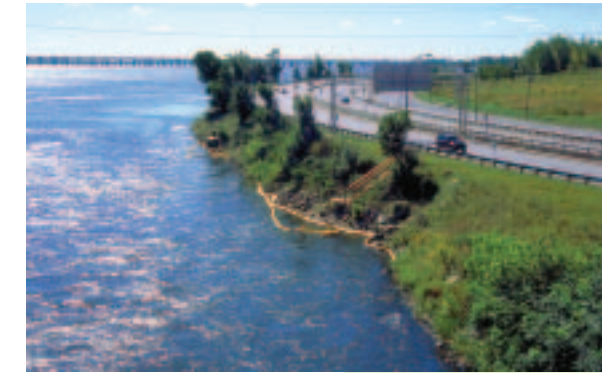
L'autoroute Bonaventure dans le secteur du Technoparc
