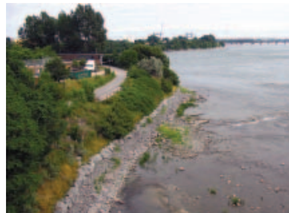
Pointe ouest de l'île Sainte-Hélène constituée de remblais
