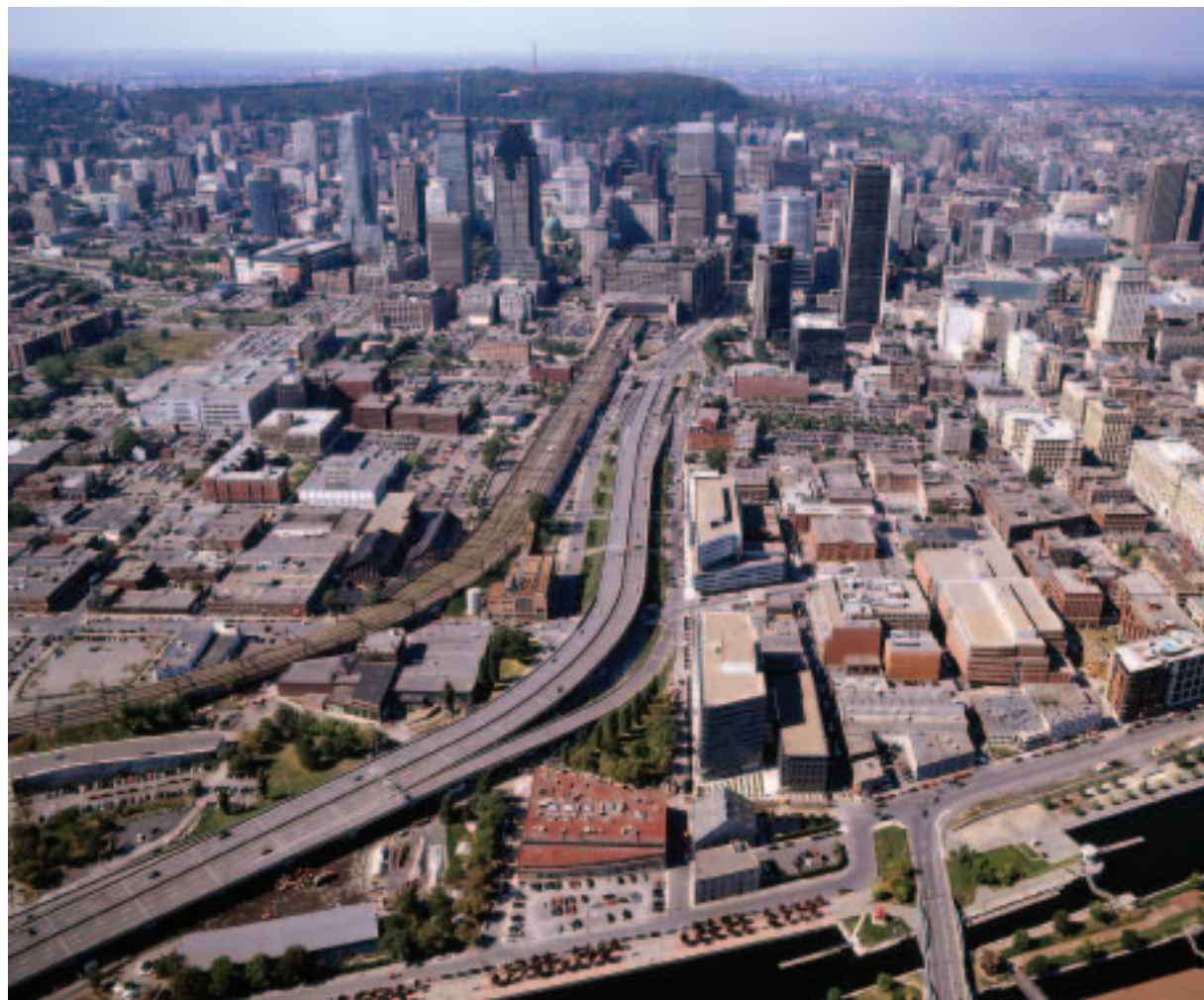
L'état actuel de la principale porte d'entrée au centre des affaires
