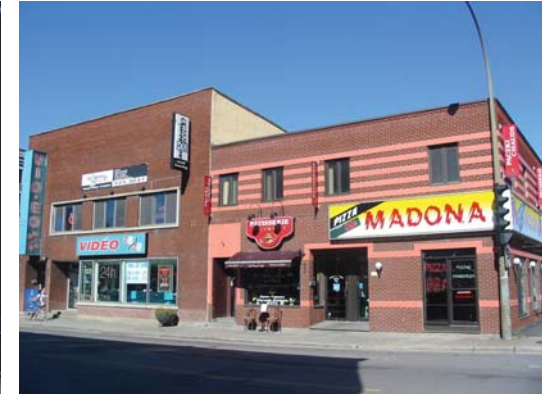
Ontario intersection Frontenac, en regardant vers l'ouest.
