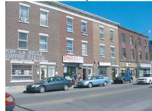
Ontario intersection Gascon, en regardant vers l'est
