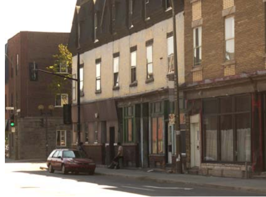
Figure 2 - Cadre bâti en déclin sur la rue Sainte-Catherine est
