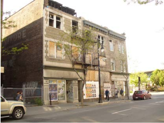
Figure 1 - Terrain vacant et bâtiments abandonnés à côté du métro Papineau
