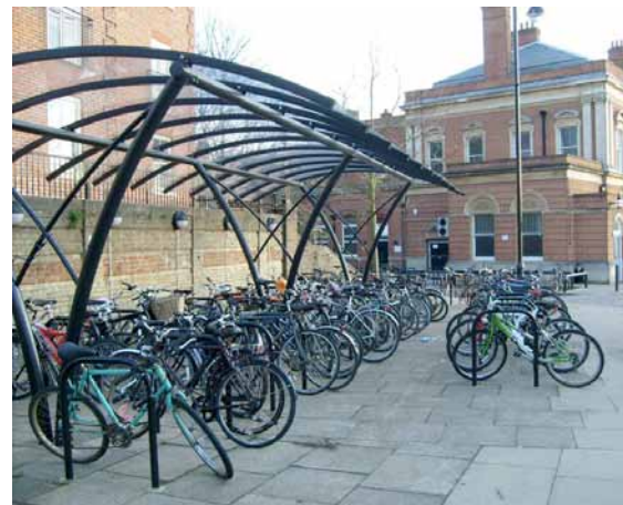
PHOTO 43 Aire de stationnement pour vélo couverte
