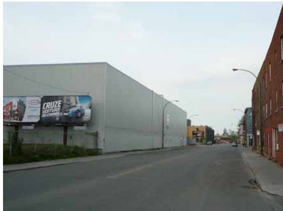
PHOTO 2 L'entrepôt frigorifique vu vers l'ouest de la rue Ontario.
