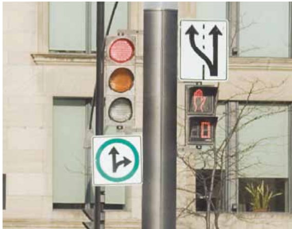
PHOTO 30 Feux piétons à décompte numérique.
