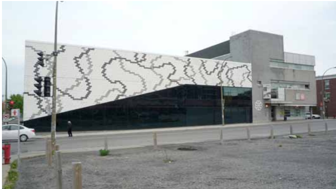
PHOTO 7 Centre Jean-Claude Malépart et la nouvelle piscine de l'intersection de la rue Du Havre.
