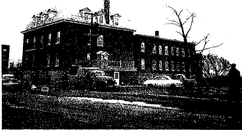
Figure 21 : Le Centre de réhabilitation Meurling en 1956. À noter la modification au portique et le nouveau recouvrement de toiture en métal. (AVM. Photographies anciennes. Z-660-2).
