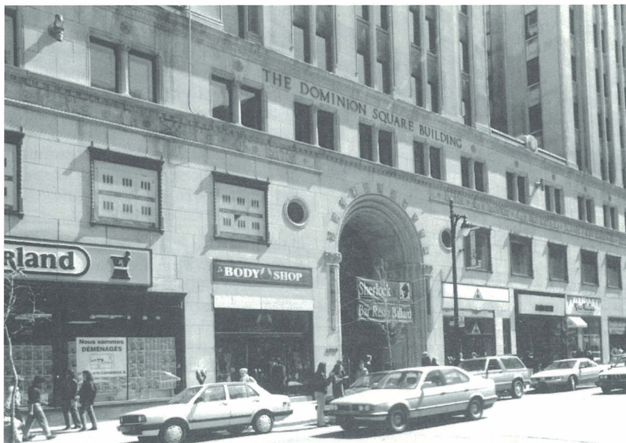
La division verticale des façades peut faciliter la lecture des plus grands bâtiments et permettre d'évaluer les distances.
