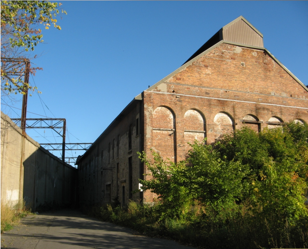
Usine de gaz (John Ostell, architecte, 1848) Surhaussé par Hohn Spiers en 1861
