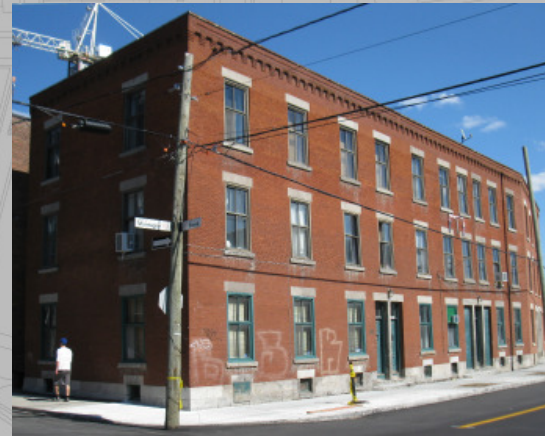
8. Immeuble à appartement, rue de la Montagne.
