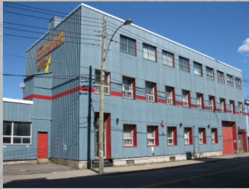
23. Bâtiment industriel/commercial type, rue de la Montagne.
