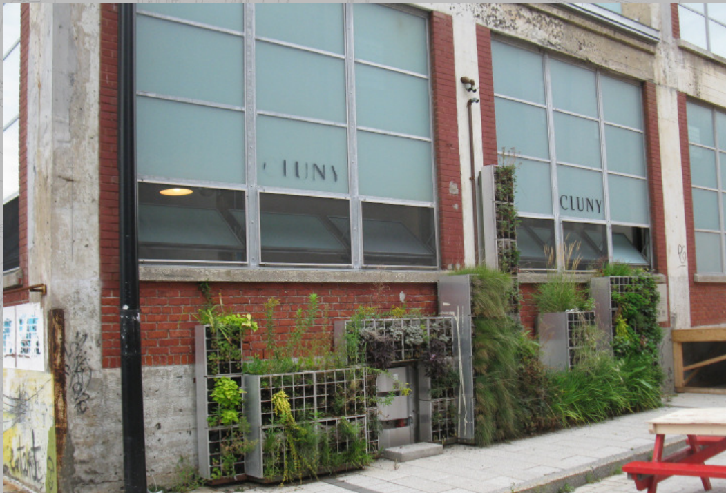
34. Vue sur un ancien complexe industriel, aujourd'hui vacant, depuis la rue Saint-Paul Ouest.
