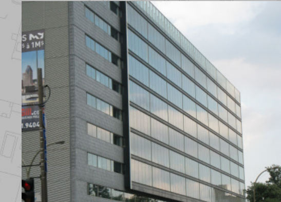
21. Immeuble à bureaux de SAP Canada, coin Duke et de la Commune.
