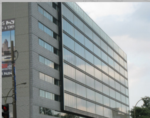
21. Immeuble à bureaux de SAP Canada, coin Duke et de la Commune.
