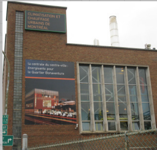
31. Climatisation et chauffage urbains de Montréal, coin Wellington et Nazareth.
