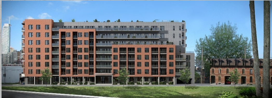
18. Immeuble résidentiel Carré de la Montagne, en construction, coin Ottawa et de la Montagne.
