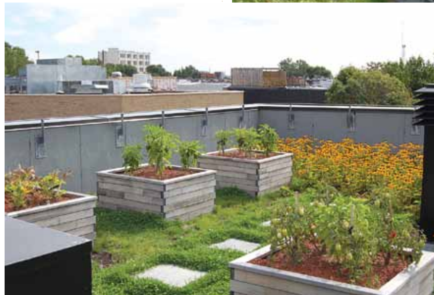
Projet résidentiel Méta D'âme, Arrondissement de Ville-Marie : culture en bac sur la toiture verte de l'immeuble (programme AccèsLogis, Direction de l'habitation)
