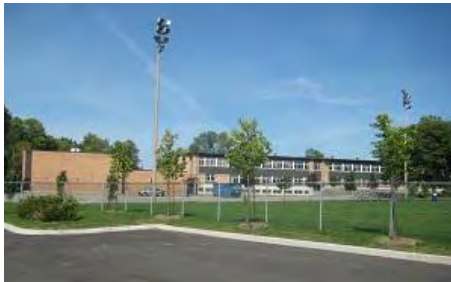
École primaire Harfang-des-Neiges/Pavillon Pierre-Lauzon
