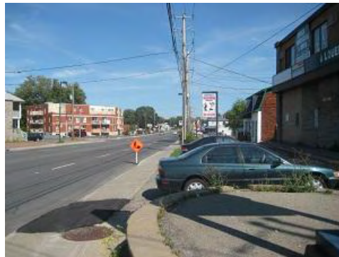
Stationnement en façade : situation conflictuelle avec le piéton. Boulevard Gouin
