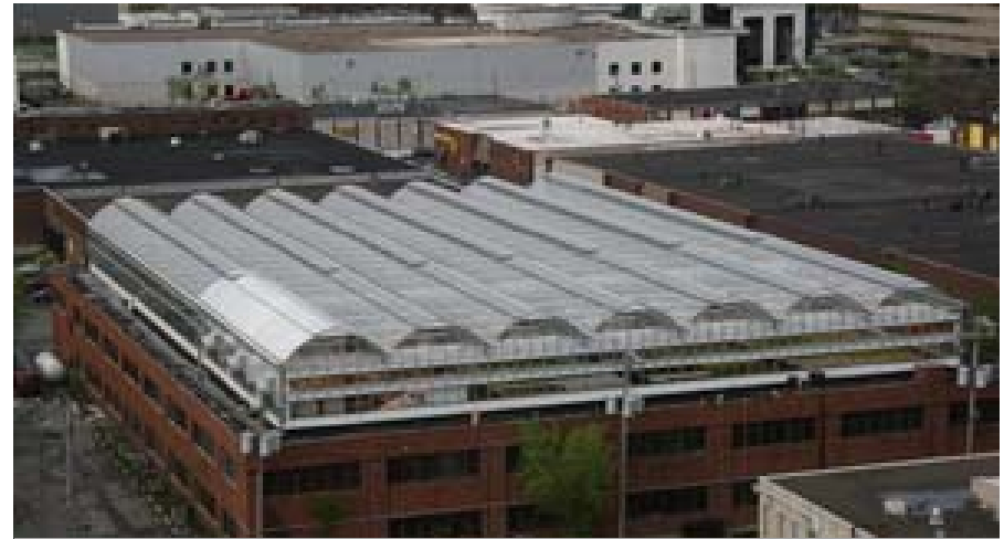
Serre maraîchère sur un toit (Fermes Lufa)
