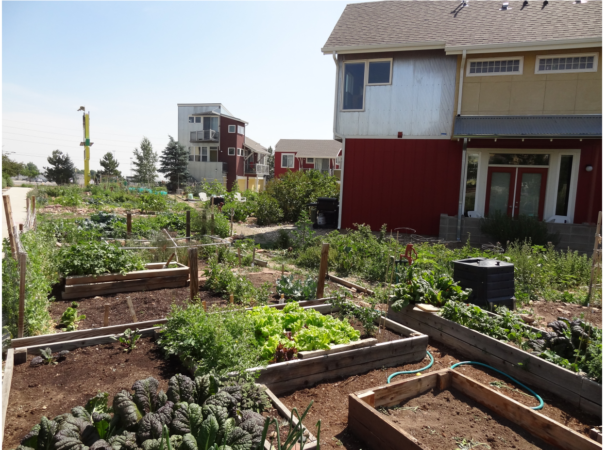
Un jardin communautaire intégré dans le plan d'ensemble d'un développement immobilier à Boulder au Colorado
