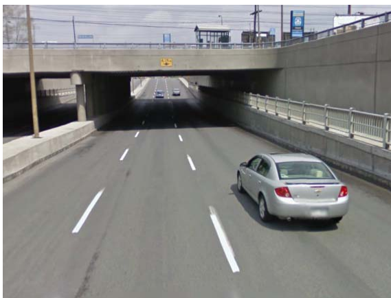
Photo 4 : Avant le viaduc. Nécessité d'installation d'un panneau de signalisation avancé fixe annonçant les feux de circulation
