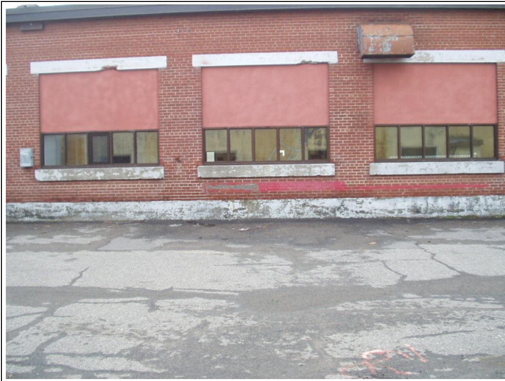
Photo No 2 – Localisation des réservoirs souterrains R4 et R5.
