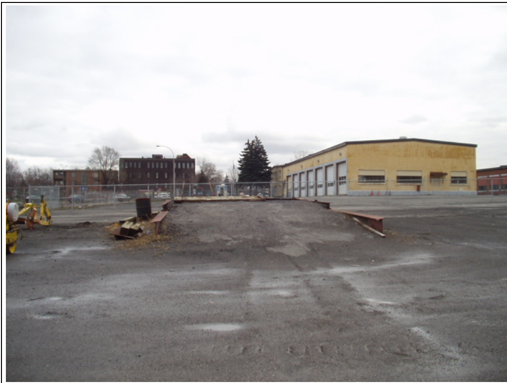
Photo No 4 – Vue de la rampe de chargement située à l'est du bâtiment A.
