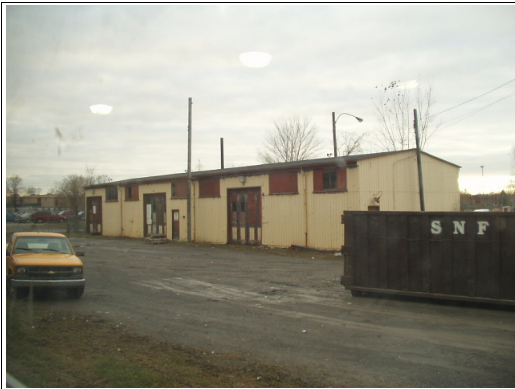
Photo No 8 – Vue du bâtiment C.
