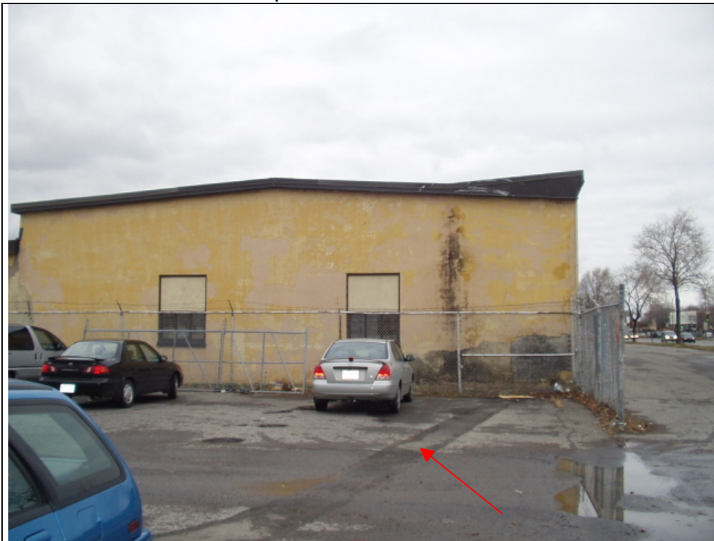
Photo No 6 – Vue de la tranchée, située entre les bâtiments A et B, qui est contaminée.
