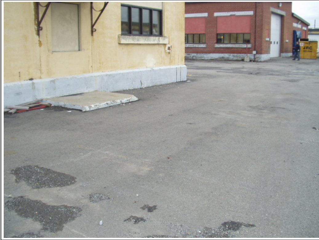
Photo No 1 – Localisation des réservoirs souterrains R1 à R3.
