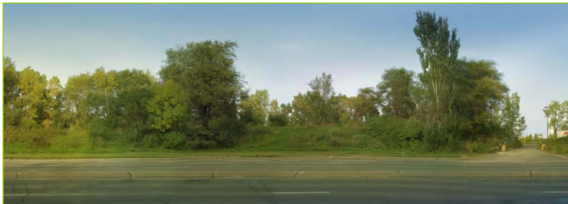
VUE DU TALUS
