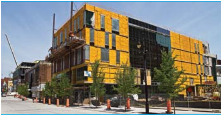
Rue Sainte-Catherine, chantiers de La Maison du développement durable et du 2-22.
