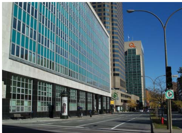
62 – Les façades monolithiques du boulevard René-Lévesque
