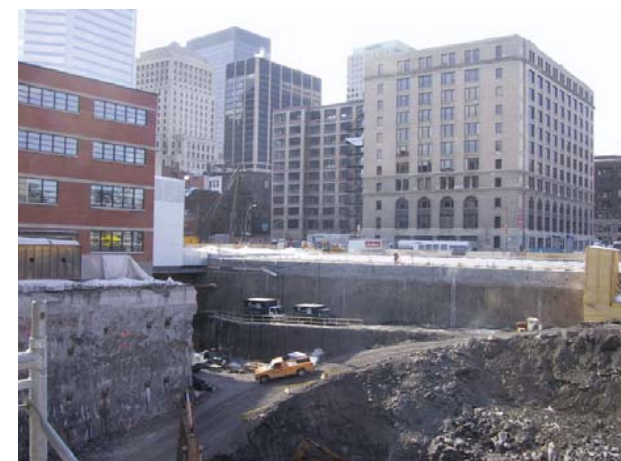
32 – Le recouvrement de l'autoroute Ville-Marie (2001)
