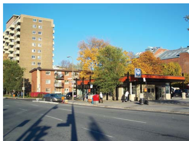
17 – La station de Métro Saint-Laurent et les Habitations Jeanne-Mance
