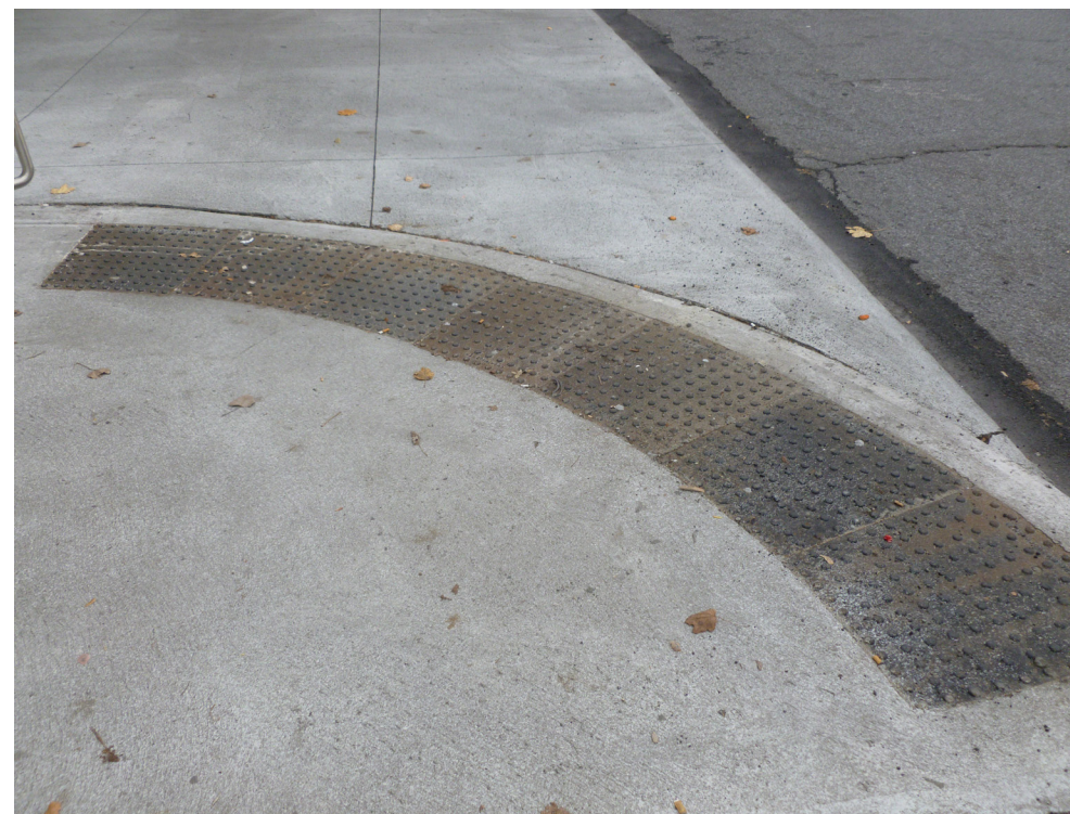
Source: Intersection d'une rue avec un panneau podotactile
