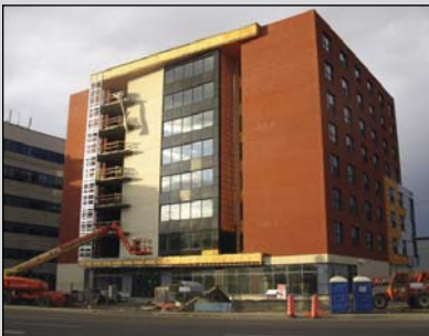
La construction d'un centre de soins intermédiaires sur l'avenue du Parc.
