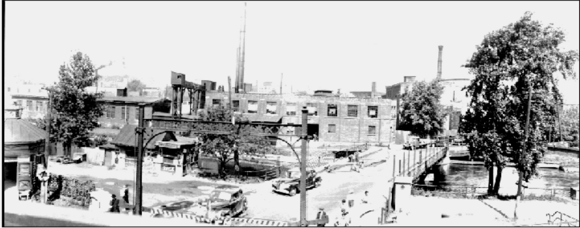
Complexe industriel au nord de l'écluse Saint-Gabriel (site de la Sonoco), Photo 1942, Bibliothèque et archives Canada
