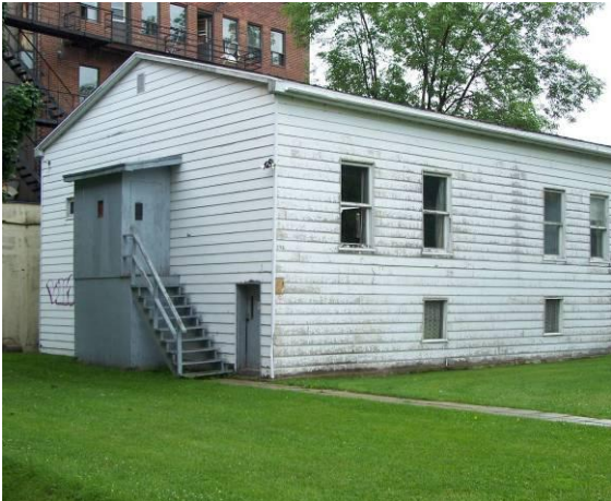
237 : Façades ouest et nord du bâtiment. Source: MBrodeur consultant inc. Photo Éric St-Louis.
