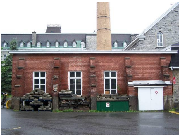
274 : Façade nord de l'entrepôt à charbon. Source : MBrodeur consultant inc. Photo Éric St-Louis.
