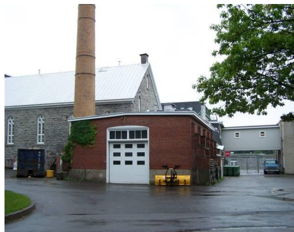
275 : Façade est de l'entrepôt à charbon. Source : MBrodeur consultant inc. Photo Éric St-Louis.
