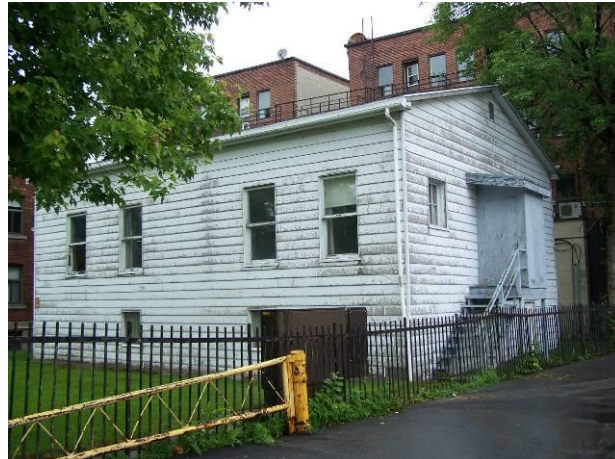
238 : Façades sud et ouest du bâtiment. Source: MBrodeur consultant inc. Photo Éric St-Louis.
