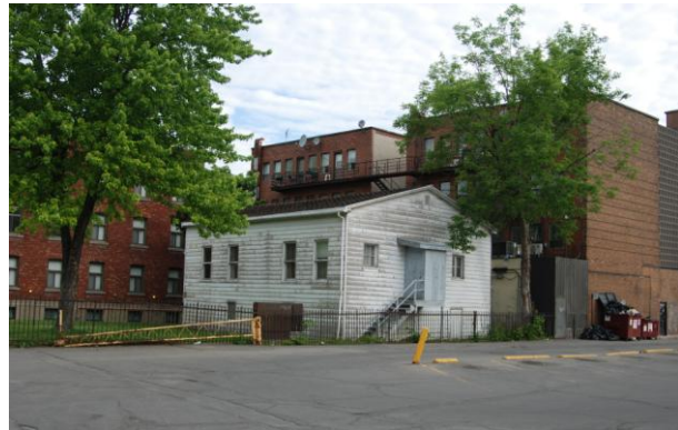
239 A : Façades sud et ouest du bâtiment dans son contexte d'insertion. Source: MBrodeur consultant inc. Photo Mario Brodeur 27 mai 2012.
