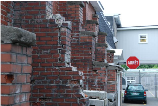
277 A : Les contreforts du côté nord. Source : MBrodeur consultant inc. Photo Mario Brodeur 27 mai 2012.
