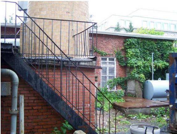
276 : Façade sud de l'entrepôt à charbon avec la cheminée. Source : MBrodeur consultant inc. Photo Éric St-Louis.
