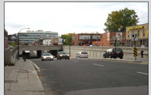
Passage de l'avenue du Parc sous les voies ferrées, à la hauteur de la rue Saint-Zotique
