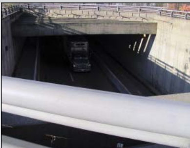
Enchevêtrement de voies et d'infrastructures, dans l'axe Clark / Saint-Urbain.
