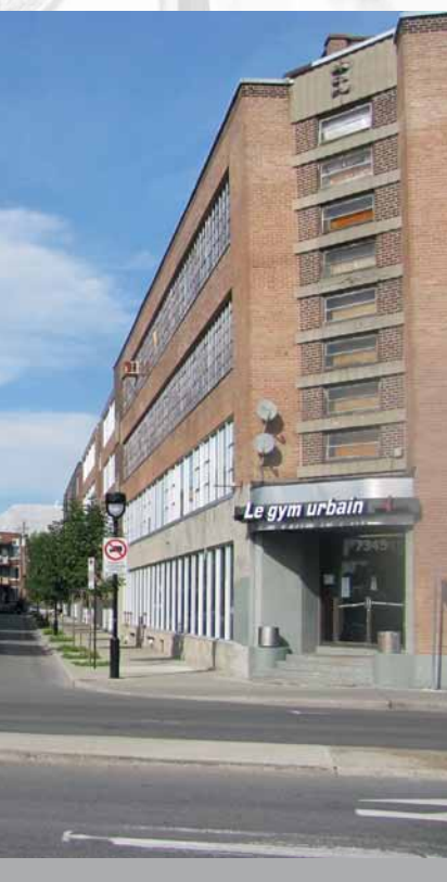
1/ Exemple de mixité d'usages et de composition urbaine : la rue Molière, à l'est du secteur.
