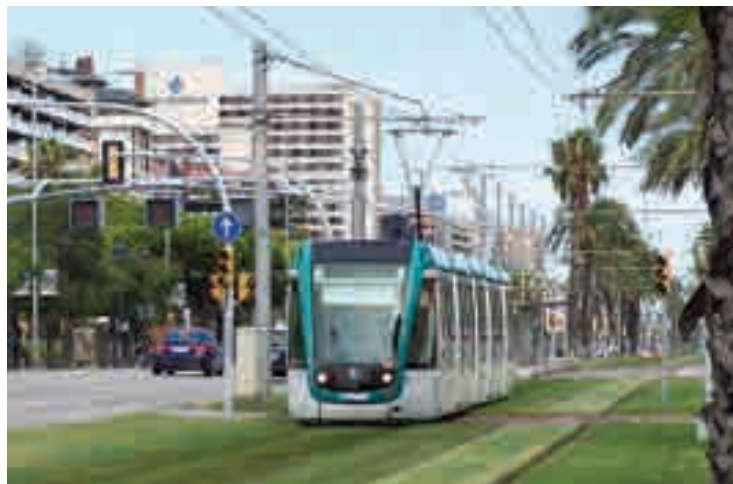
Tramway sur le prolongement de l'avenue Diagonal
